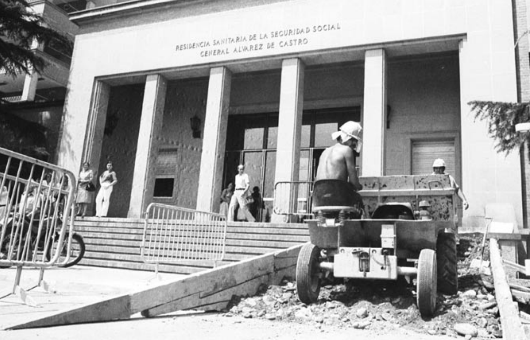
> Obres d'ampliació. Treballs a la porta principal d'accés. Any 1982. Foto: Joan Comalat, Diputació de Girona (AIEMB).
