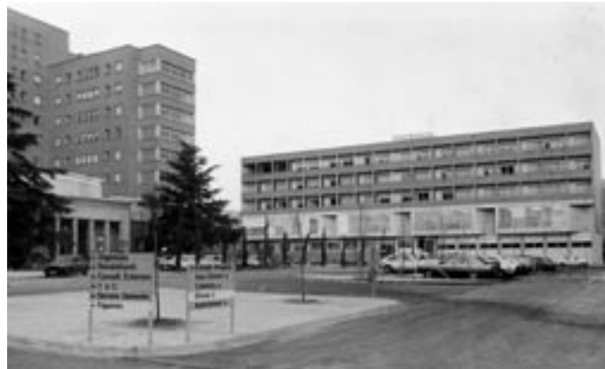
> Final de les obres d'ampliació. Any 1987. Foto: El Punt.
