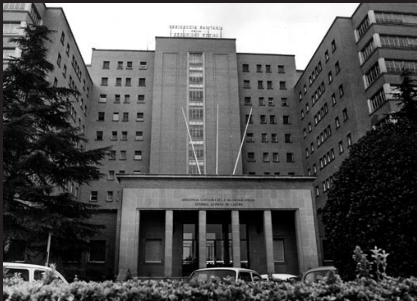
> Façana de la Residència. Any 1975. Foto: Fons COMG.
