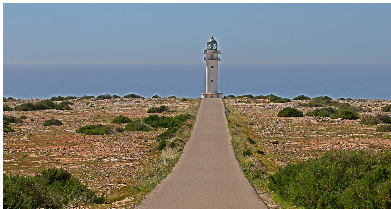
Figura 13. Desde el faro del Cap de Barbaria (Formentera), enclave más meridional del archipiélago, como ya indica el propio topónimo, se otea el mar que baña las costas norteafricanas
