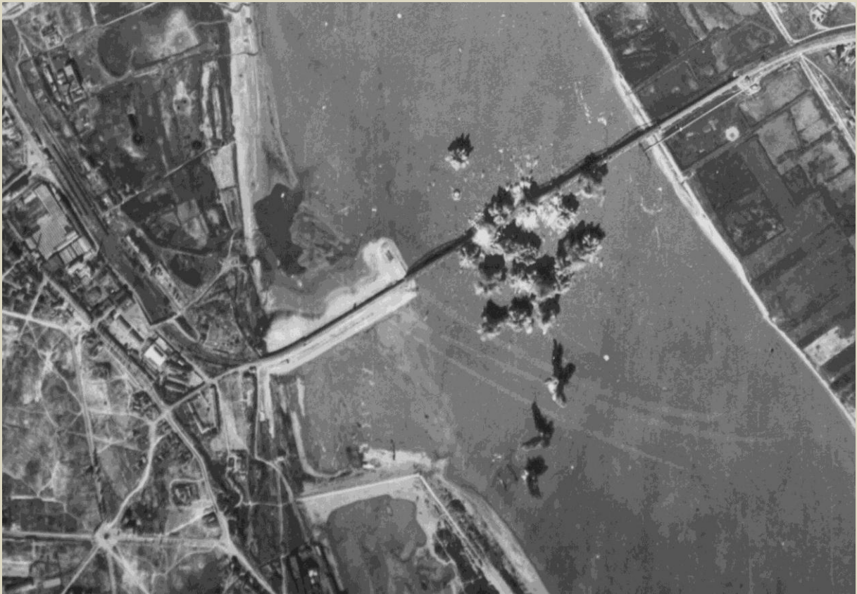
Belgrad, Eisenbahnbrücke bei Pancevo, 3.9.1944
