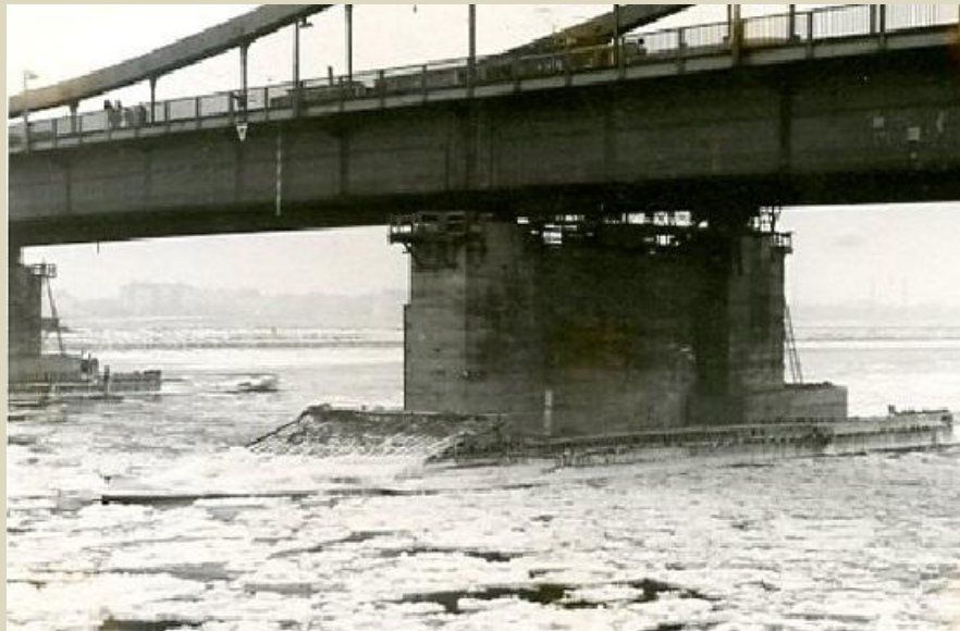
Der Hilfspfeiler am rechten Donauufer.
