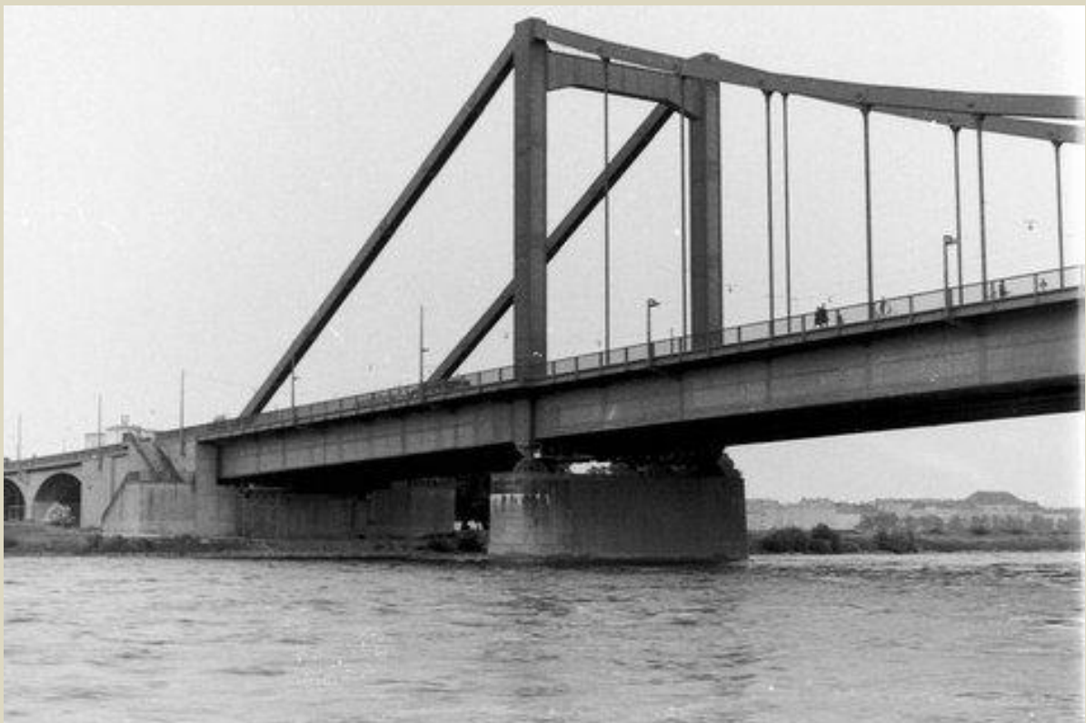
Die beiden zur Sprengung vorgesehenen nördlichen Brückenpfeiler.
