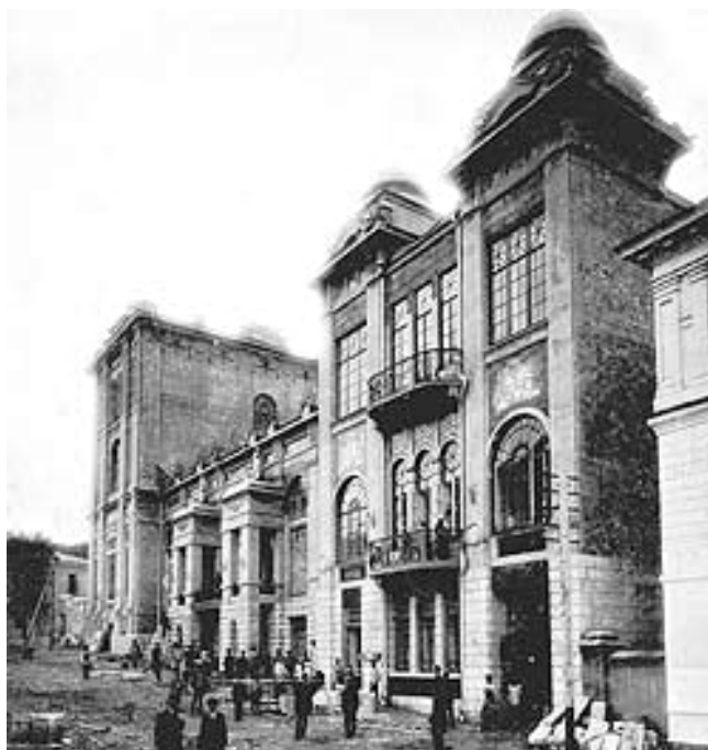
Рис. 9. Завершение строительства Всесословного клуба. Фотография 1915 г.
