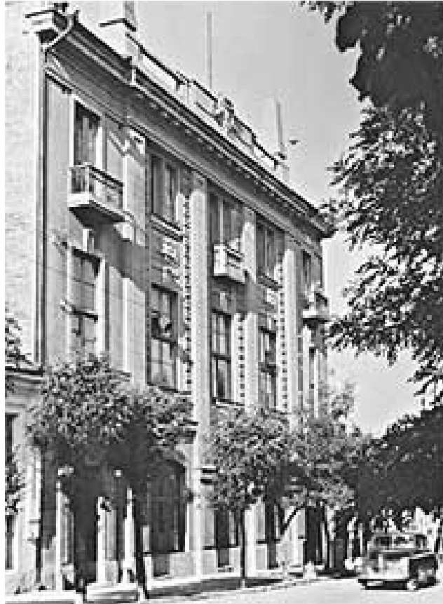
Рис. 17. Здание Азовско-Донского банка. Фотография середины XX в. ПКМ. НВФ. 3050/19
