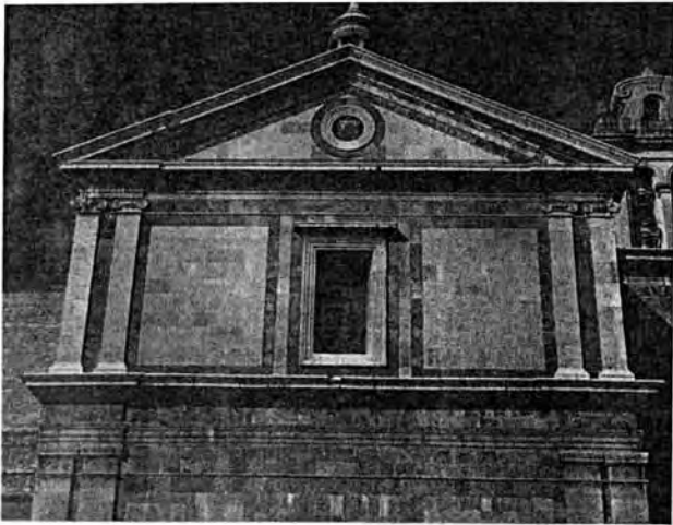
Figure 11. Giuliano da Sangallo, Santa Maria delle Carceri, Prato (begun 1485).
