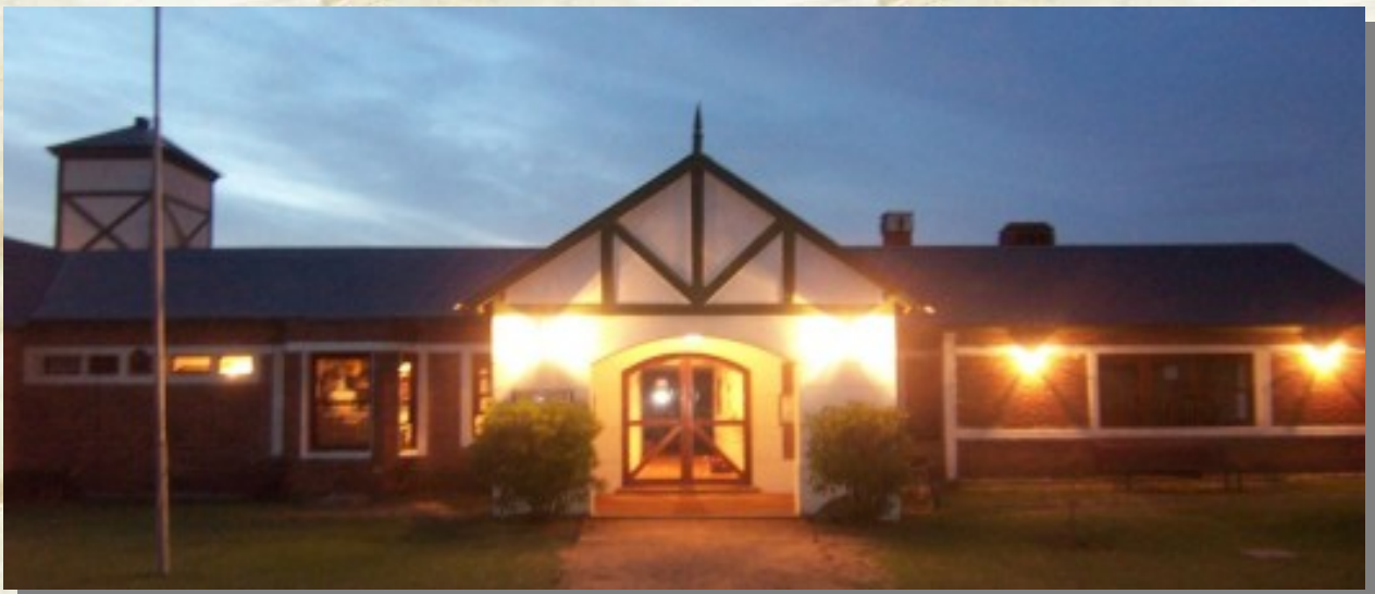
La sede actual del MVCC.
