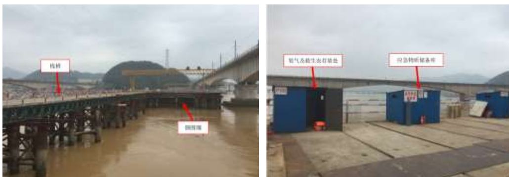
图 7.5-8 施工栈桥及应急物资现场调查图
