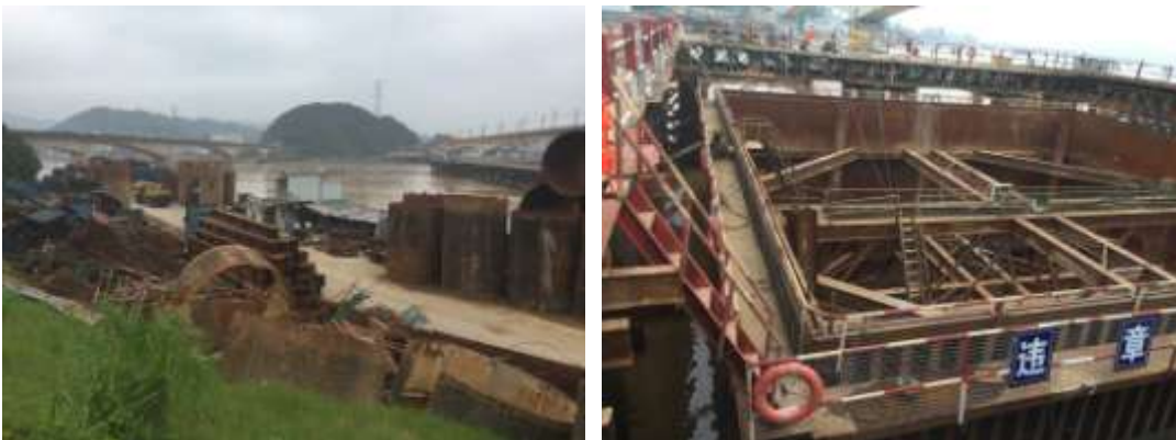
图 7.5-7 施工材料堆放及钢围堰现场调查图
