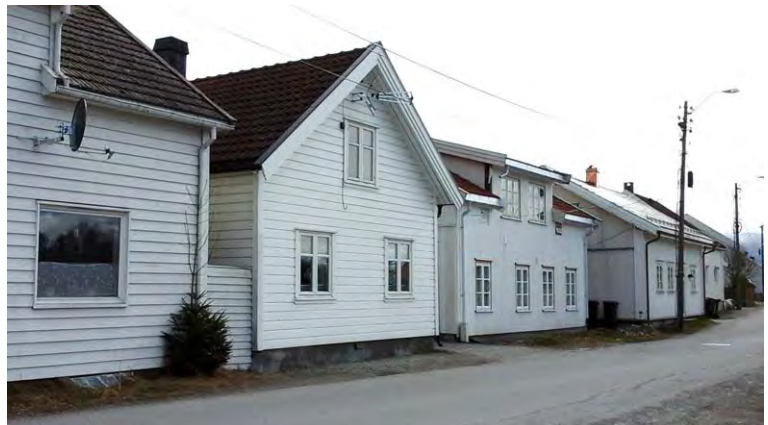
Gamle hus på rad og rekke i Dynge. Flere er omfattende endret over tid, men hvert hus er viktig som del av dette miljøet.
