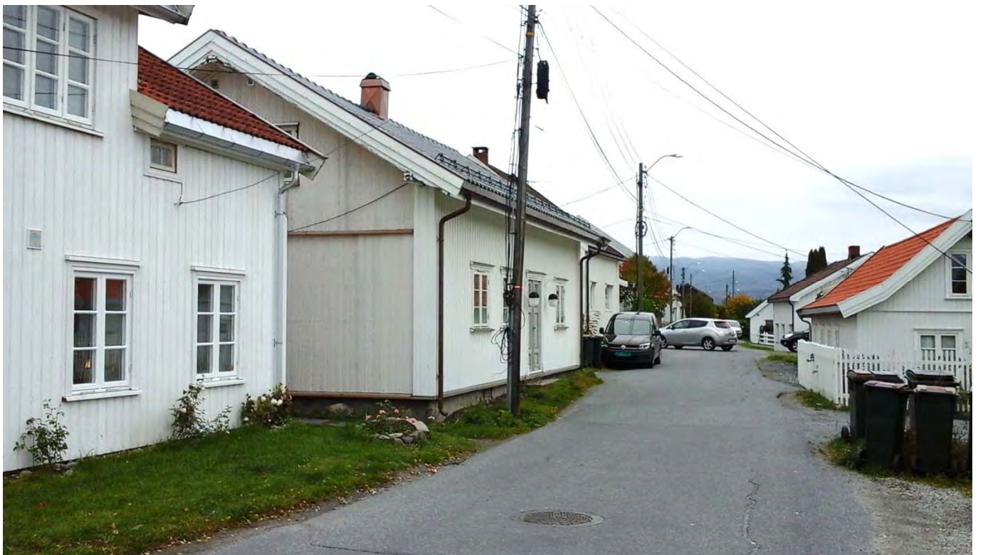
Dyngje sett fra krysset ved Hobbelstadgata og nedover mot Gamle-Hokksund. Til venstre ligger Dyngje 54 og 52, som ligger lengre ut i gata. På motsatt side Dyngje 51 med kinavipp som daterer taket til første halvdel av 1800-tallet.
