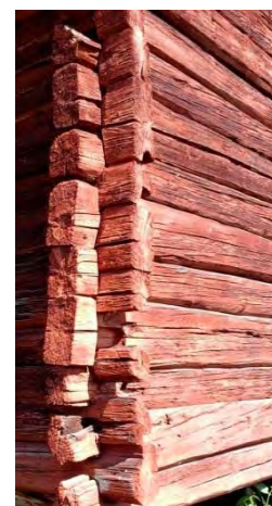
Endringer i lafteteknikken over tid gjør det mulig å gi en grovmasket datering av laftevegger.
