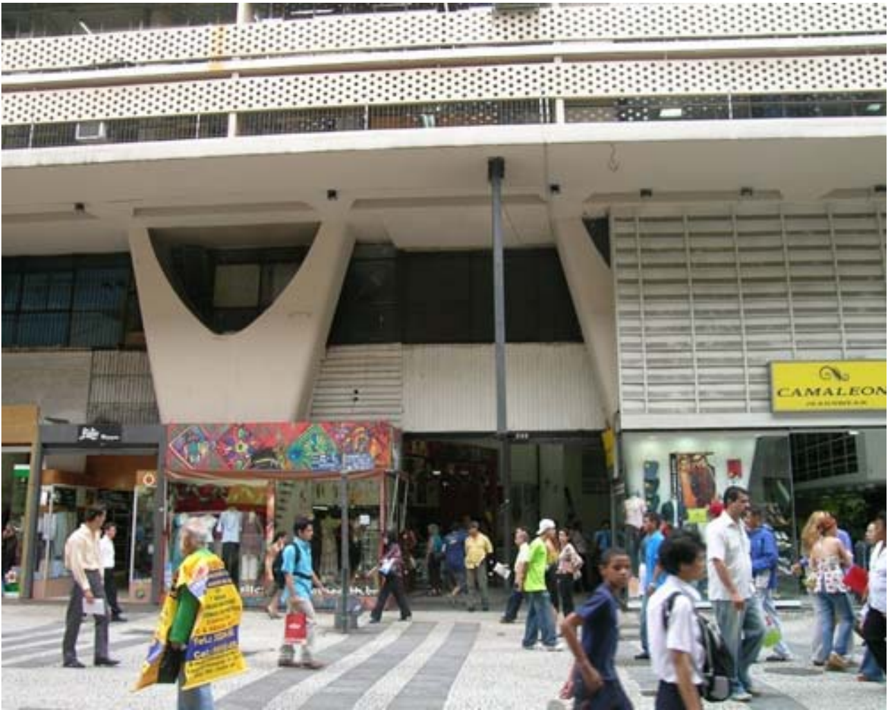
Figura 6 – Pilares em forma de “V”
