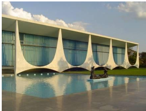
Figura 64 – Palácio da Alvorada. Fonte: Domínio Público.
