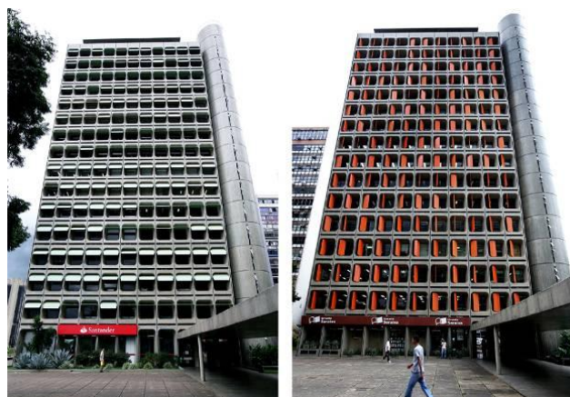
Figura 78 – Athos Bulcão. Sem título, 1975, brises em fibra de vidro pintados na cor verde. Figura 79 – Athos Bulcão. Sem título, 1975, brises em fibra de vidro pintados na cor laranja. Acervos Edifícios Camargo Corrêa e Morro Vermelho.
