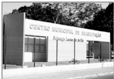
Centro de Reabilitação Municipal “Solange Lana de Ávila”. 2012. Foto: Guilherme Soares.
