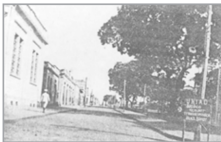
Fig. 2 (Rua 18 na área central – ano 1924)
