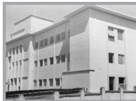
Pavilhão da Maternidade, inaugurada em 1955. Acervo: Santa Casa de Misericórdia de Barretos.
