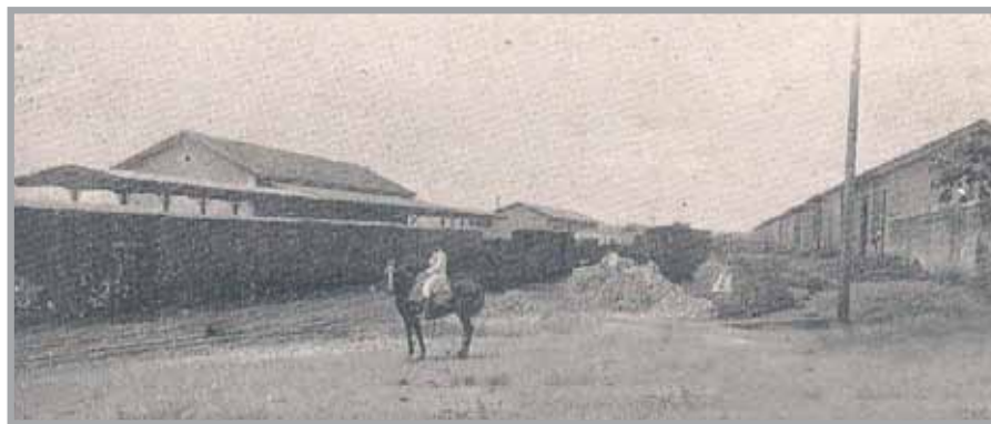
Antiga Estação de Barretos, construída em 1912. A foto é de 1918. Fonte: "Álbum Ilustrado da Companhia Paulista de Estrada de Ferro".
