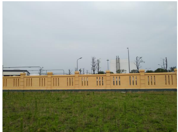
洋湖垵主所西侧（污水处理站）
