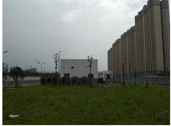
洋湖垵主所东侧（35kV 混合变电所）
