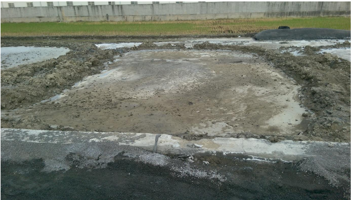
圖 5-1-14 水力回填灌注完成後 28 天狀況(試驗坑 II)
