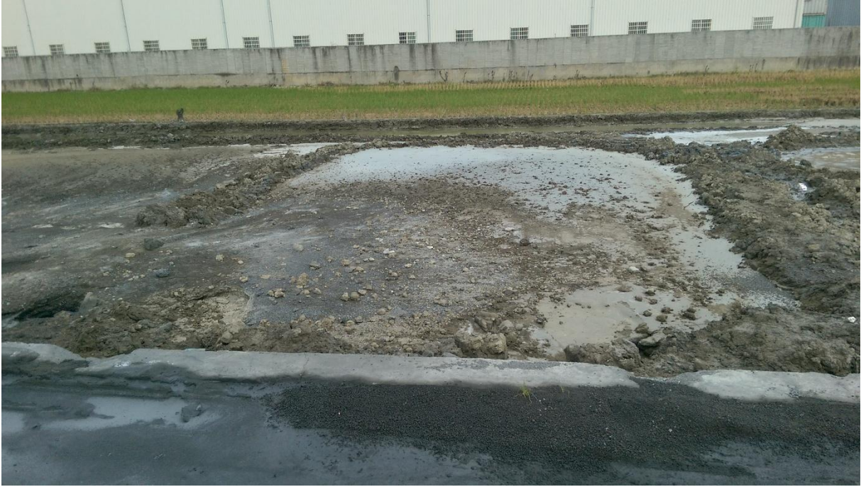
圖 5-1-15 水力回填灌注完成後 28 天狀況(試驗坑 III)
