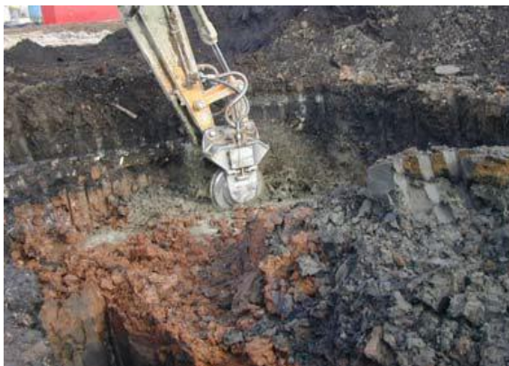
(c) 現地攪拌機混合土壤與水泥
