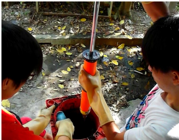
圖 4-3-10 水泥漿直接注入交通錐進行攪拌
