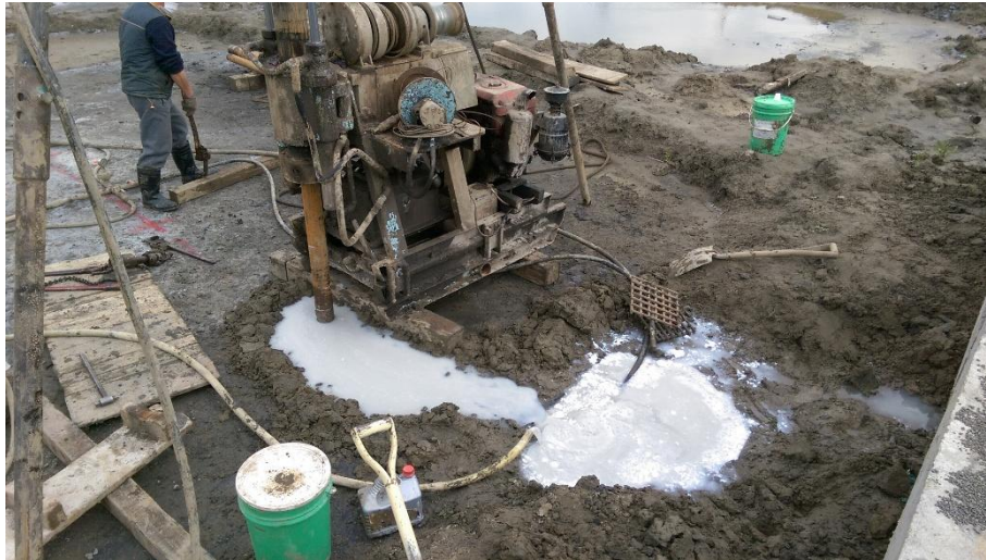
圖 5-3-3 鑽機及鑽孔定位
