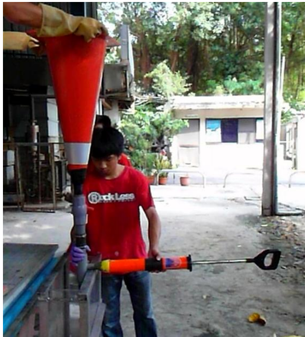
圖 4-2-4 交通錐裝上水泥灌注槍及混合管
