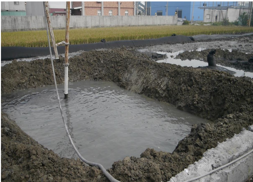
圖 5-1-11 底灰漿混合水泥漿水力排放至試驗坑
