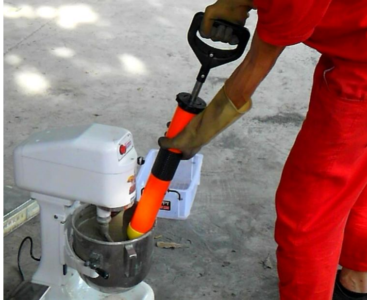
圖 4-2-2 水泥灌注槍抽取水泥漿
