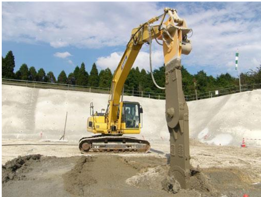
圖 2-3-3 WILL 工法施工情形和主要工作處理機
