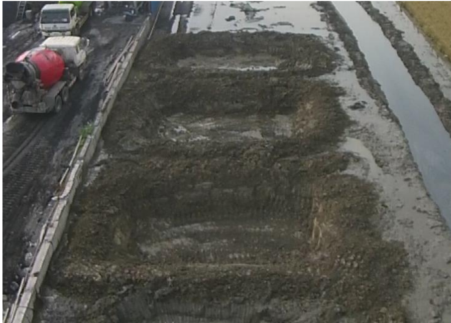
圖 5-1-6 試驗坑開挖完成現地照片
