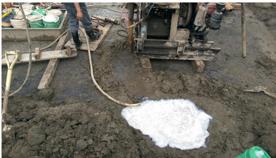
圖 5-3-4 增加取樣土樣穩定性之超泥漿及皂土混合液
