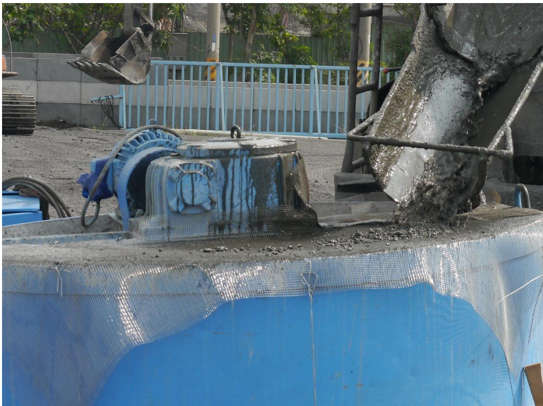
圖 5-1-9 水泥漿注入低速攪拌桶
