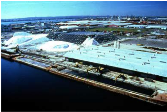
(a)紐約港疏浚底泥 S/S 處理照片
