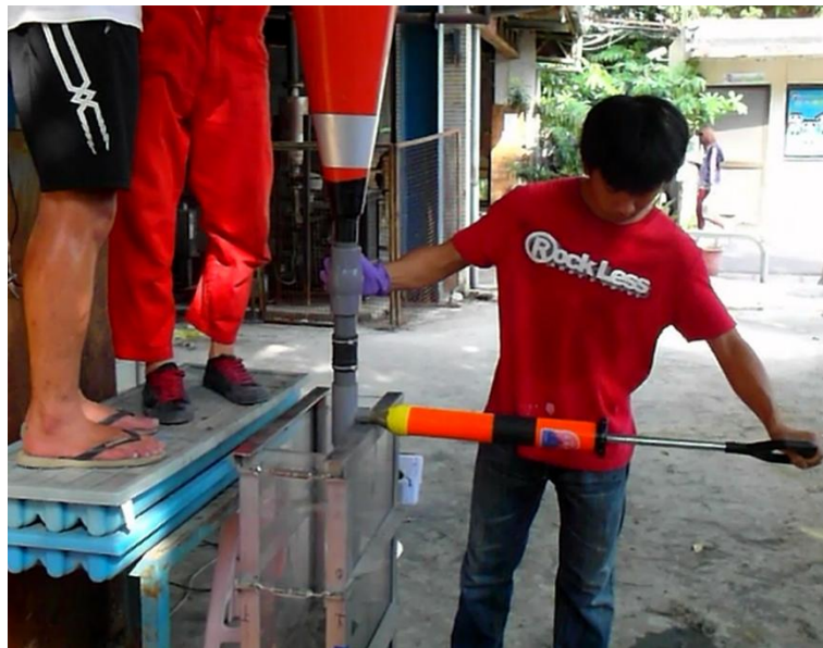
圖 4-2-7 打開球閥開關注入水泥漿
