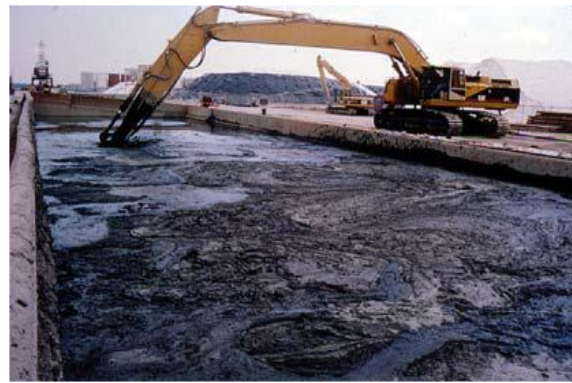
(b)機具攪拌混和水泥及土壤
