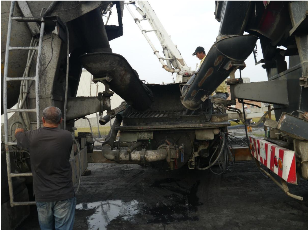
圖 5-1-8 底灰漿注入泵浦車
