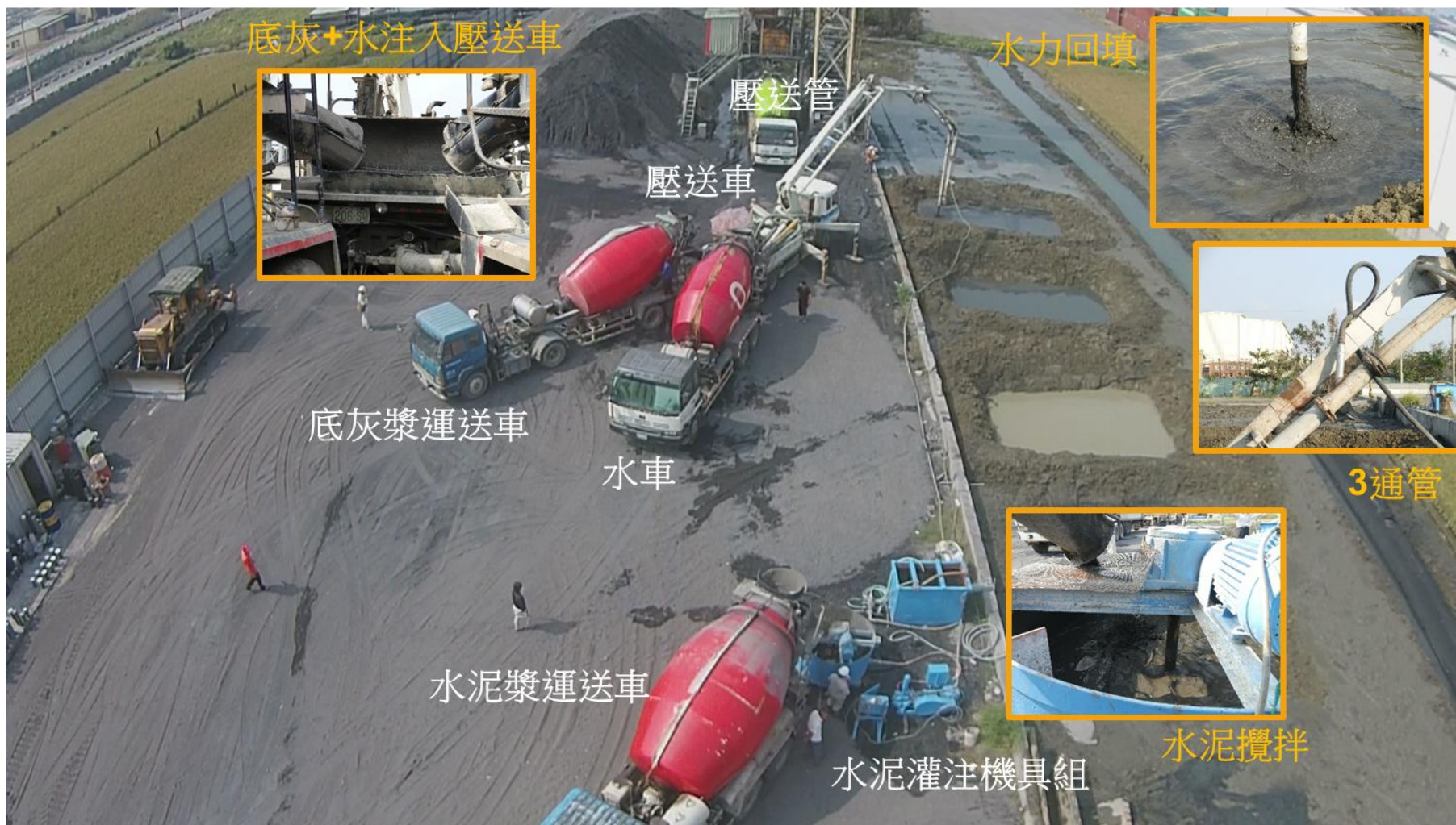
圖 5-1-12 水力回填灌注試驗現地實作照片
