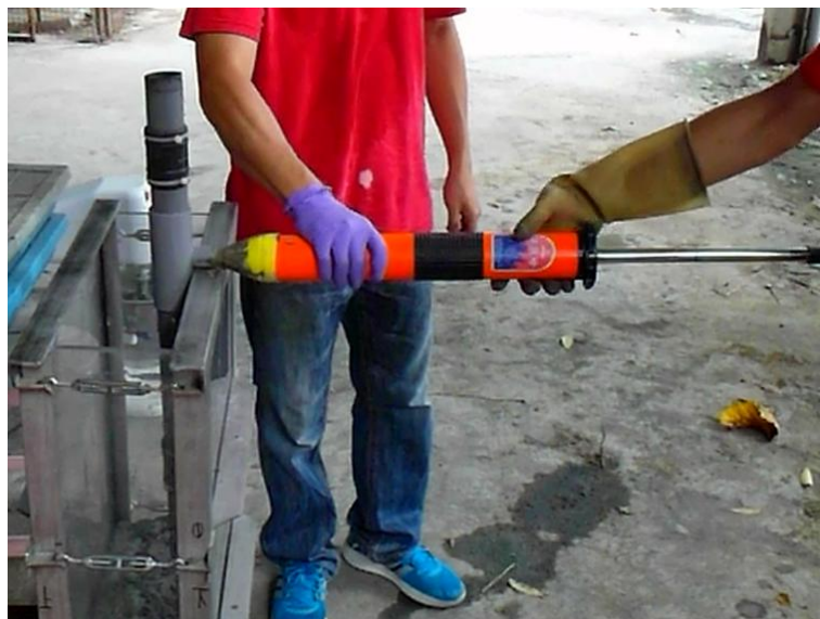
圖 4-2-3 水泥灌注槍裝上 PVC 三通管及混合管
