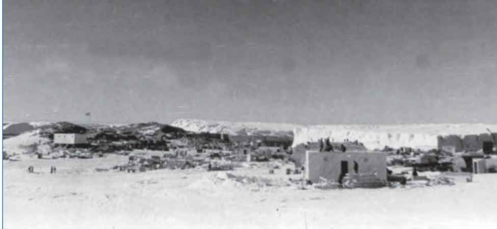
Строительство обсерватории Мирный.
