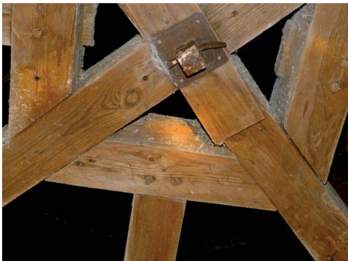
Fig. 174. uniones de peinazos y parte inferior y pasador de la espiga del nabo. F. A.
