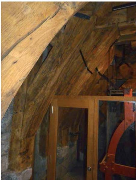
Fig. 117. detalle de pies derechos apoyados en ménsulas, y jabalcones bajo el telar de arranque del chapitel.
