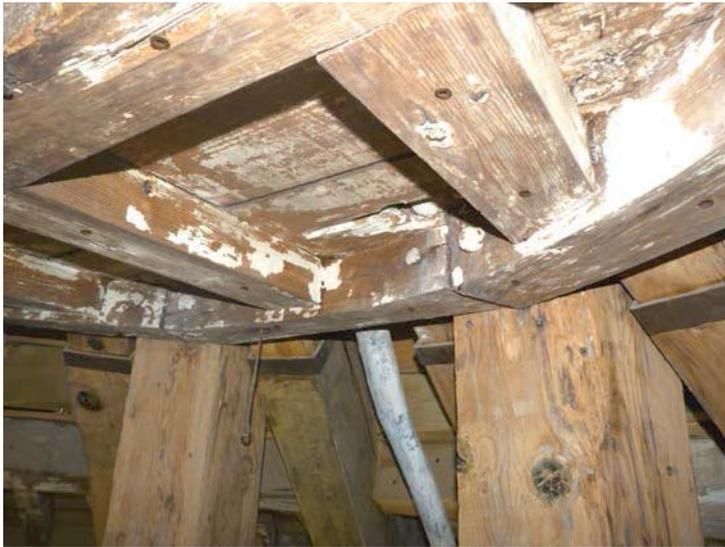
Fig. 240. Cercos interiores a los pies derechos al que ensamblan los pares en cabeza. F.A.
