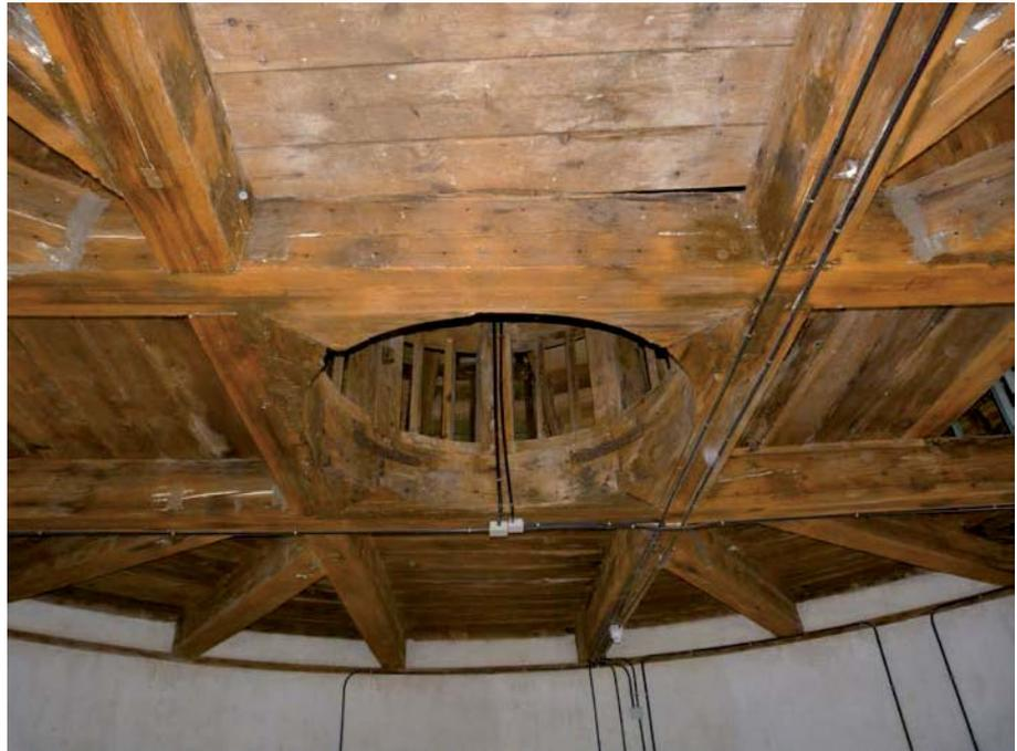
Fig. 234. Detalle del encuentro entre un tirante principal de la cruz y el tirante radial que ensambla en él. F.A.
