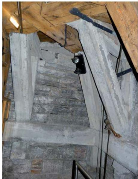
Fig. 118. detalle de una de las esquinas con estructura de hormigón imitando las piezas de madera de la armadura original. F. A. 2012
