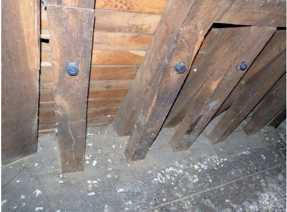
Fig. 126. Idem anterior. Detalle de la parte inferior de las limas, pares y péndolas reforzadas por jambettes. F.A. 2012
