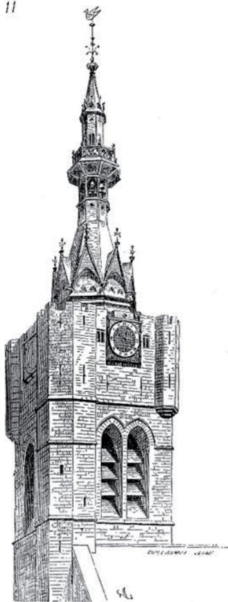
Fig. 79 Dibujo de mediados del s. XIX del Beffroi de Bethune (Francia), con su chapitel construido en torno a 1473. Violet Le Duc, *Dictionnaire raisonné ... Op. Cit. T.2. p. 195*. Tras ser destruido en la 1ª guerra mundial fue reconstruido con las mismas formas con que aparece en el dibujo
