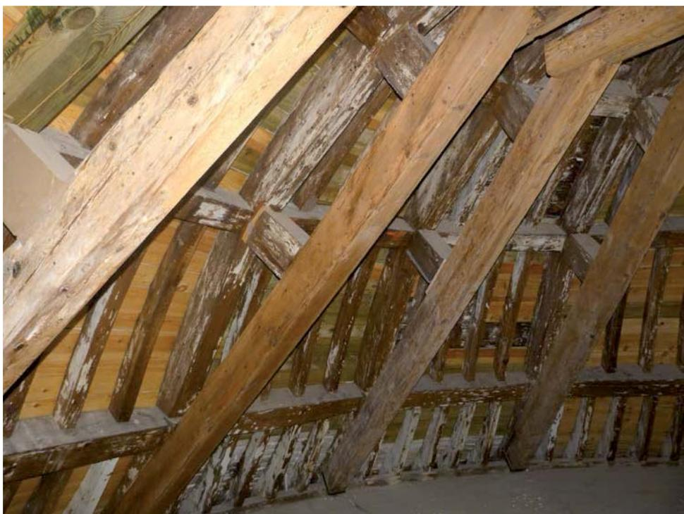
Fig. 245. Armadura de la cúpula a base de tijeras, camones, andavías y cuartones curvados F.A.
