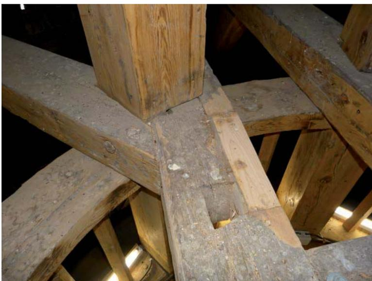
Fig. 238. Ensamble de pie derecho, y nudillo principal y secundario F.A.
