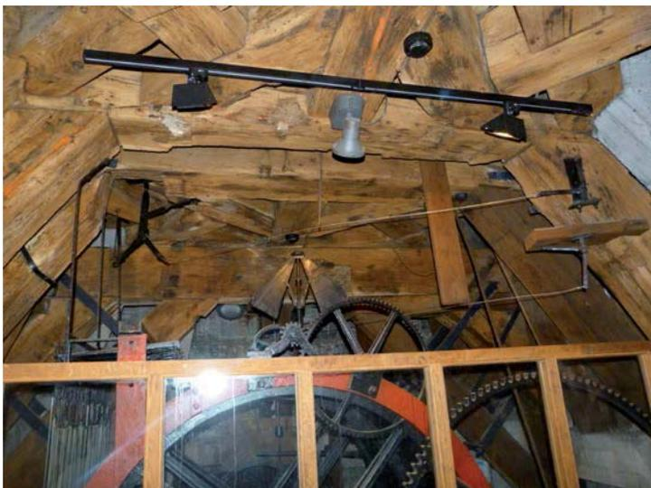
Fig. 119. Vista inferior del entramado del telar sobre el que arranca la armadura del chapitel. La viga bajo el plano del telar es un refuerzo que no se corresponde con la estructura original. F. A. 2012
