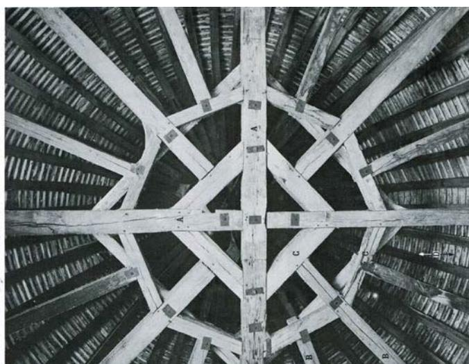
Mathurin Jousse nos muestra en dos de sus figuras la formación del telar de apoyo de una aguja sobre una torre circular. En la figura XXXI se recoge la solución de cruz monoaxil formada por los tirantes principales, mientras que en la XXXVII nos muestra el desdoblamiento del tirante en una sola dirección y a cada lado de uno de los brazos principales.
