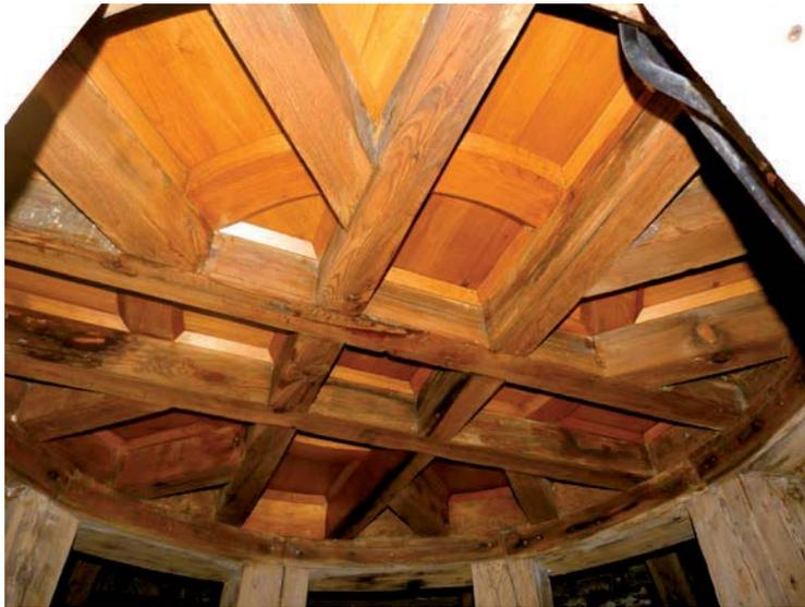
Fig. 236. Entramado horizontal situado a la altura del tercer anillo de los pies derechos en su tramo inferior F.A.
