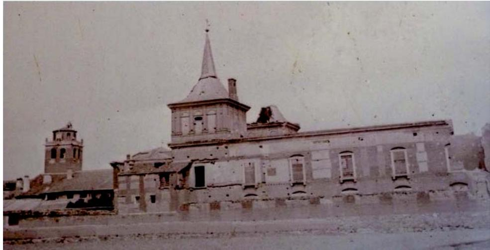
Fig. 246. Fotografía de la fachada sur del palacio a principios del siglo XX, donde se puede ver el chapitel norte en estado avanzado de ruina. Fotografía de Leopoldo Torres Balbás APAG
