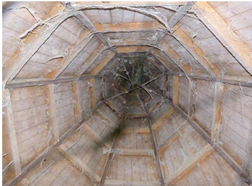
Si tomamos como modelos los que ya hemos visto con forma semejante, la armadura de madera original es posible que hubiera dispuesto en el telar de apoyo cuadrada y aguilones para asegurar las esquinas de los estribos, mientras que en los paños de los faldones, sobre las andavías, se habrían colocado cuarterones para clavar el entablado en dirección horizontal. También es probable que encontráramos dos entramados
