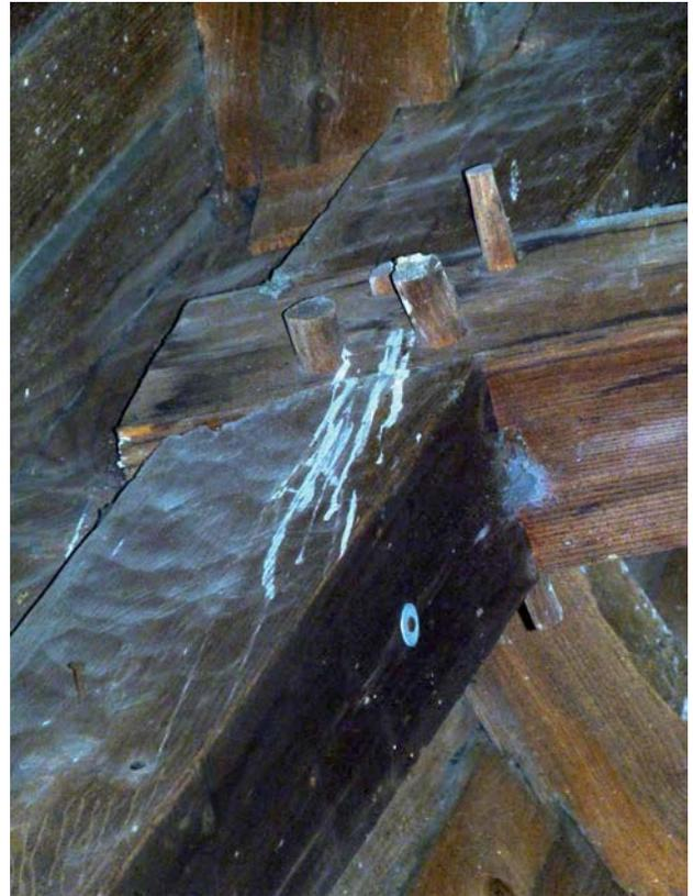
Fig. 180. encuentro del tramo superior e inferior de la tijera con el nudillo correspondiente, enlazadas mediante cuatro clavijas de madera dos superiores y dos inferiores. Chapitel de la garita sur del alcázar de Segovia. F. A.
