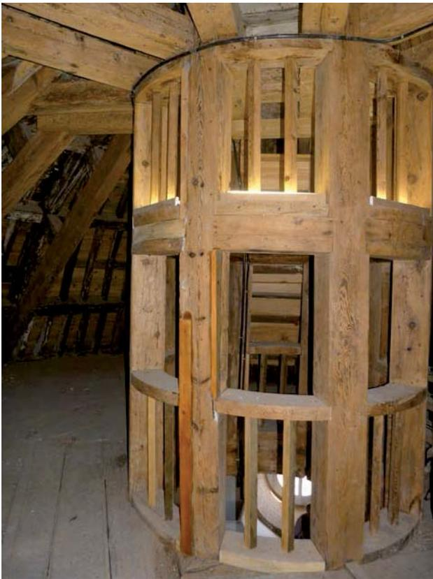
Fig. 235. Disposición de pies derechos y cercos entre el telar de apoyo del chapitel y el entramado horizontal principal de la armadura F.A.
