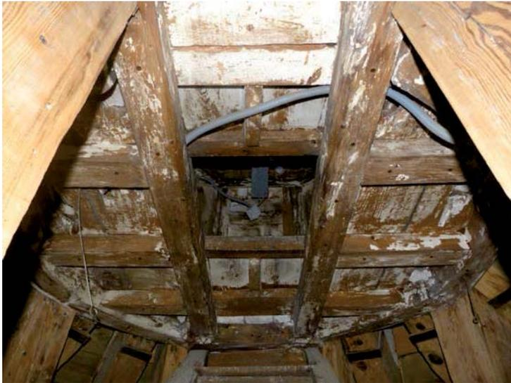
Fig. 241. Entramado reticular de fortificación del cerco de apoyo de los pares. F.A.
