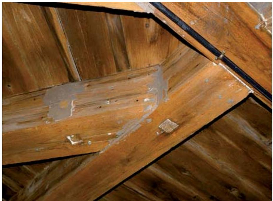
ocupa los pies derechos se sitúan sobre el cuadrado formado por el cruzamiento de los tirantes principales, el cual se redondea por su interior mediante cuñas dispuestas en sus esquinas, se dispone así un círculo que se corresponde con la base del cuerpo cilíndrico que forman los pies derechos de la linterna.
