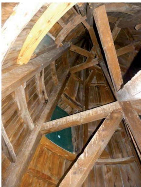
Fig. 176. Unión de jabalcones y posición del entramado intermedio. F A.
