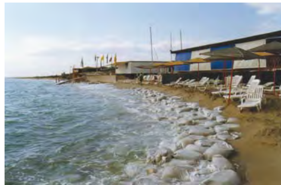
Fig. 8.6 - Vistosi fenomeni di arretramento interessano numerose spiagge del Salento. Una delle unità più colpite è quella di Marina di Ugento, attualmente difesa da una opera aderente.
