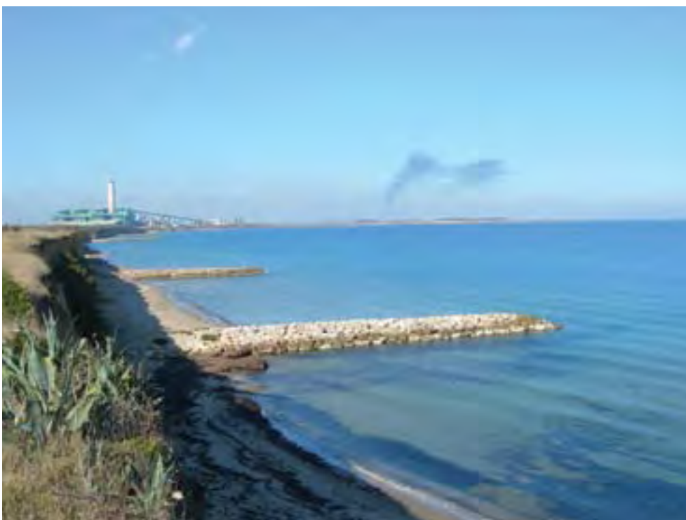
Fig. 8.2 - Il veloce arretramento della falesia in località Campo di Mare, nei pressi della centrale termoelettrica di Cerano, ha richiesto la realizzazione di numerose opere di difesa costiera.
