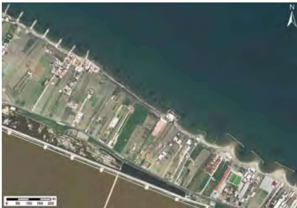
Fig. 3.6 - Tratto di costa tra le località Foce Nuova e Porto Canale, nei Pressi di Trinitapoli; l'erosione costiera, accentuata dalla pressione antropica, ha ridotto la spiaggia attuale ad una stretta fascia tra il mare e le Saline di Margherita di Savoia; le numerose opere di difesa (molte delle quali smantellate dal mare) si sono rivelate di scarsa efficacia.
