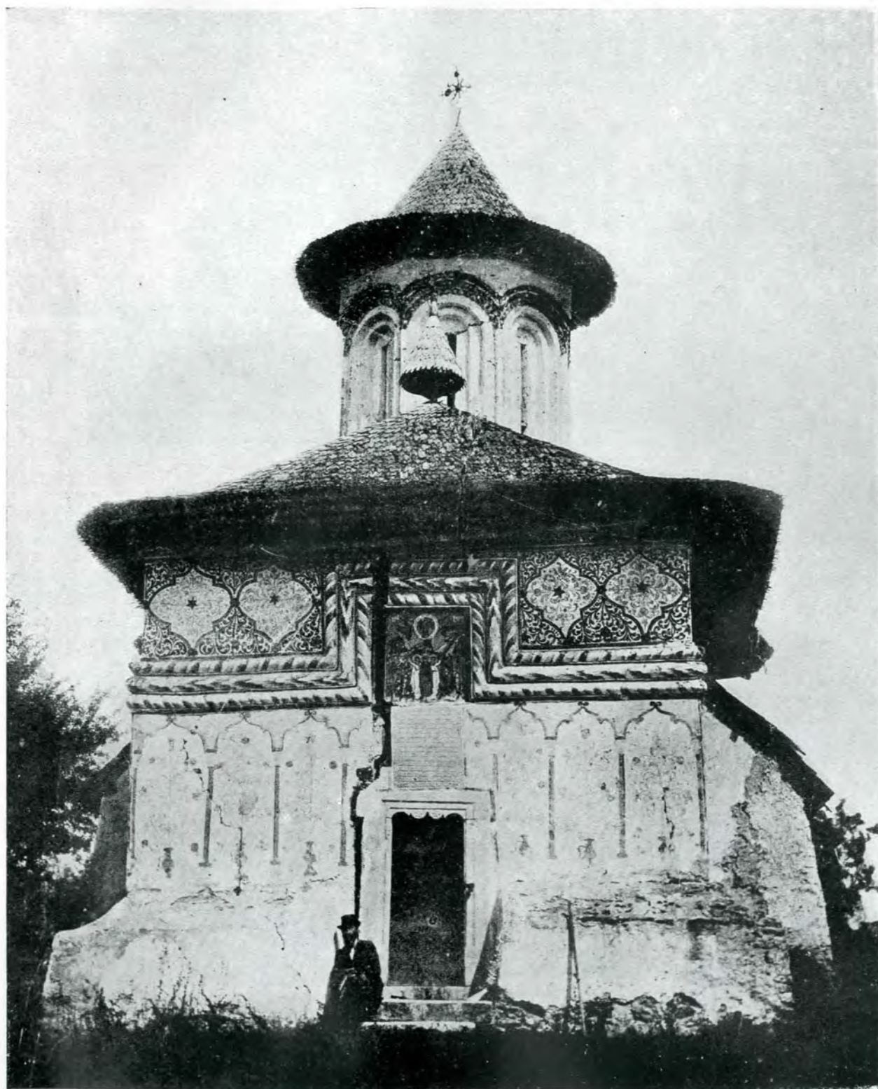
Fig. 1. — Vechea biserică a schitului Mărculești-Flămânda, lângă Câmpulung-Muscel — azi dărâmată. Fotografie comunicată de d-l Arhitect Paul Smarandescu, profesor la Facultatea de Arhitectură.
