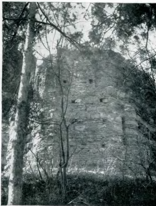
Fig. 4. — Détail de la façade Est de San Nicoara
