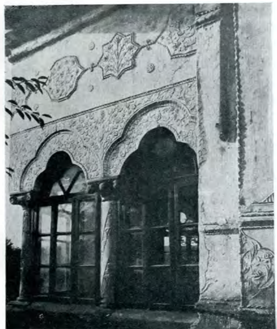
Fig. 227. — Détail de la décoration en stuc de la façade.
