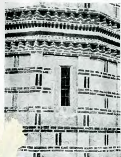
Fig. 122. — Détail de Căluu
