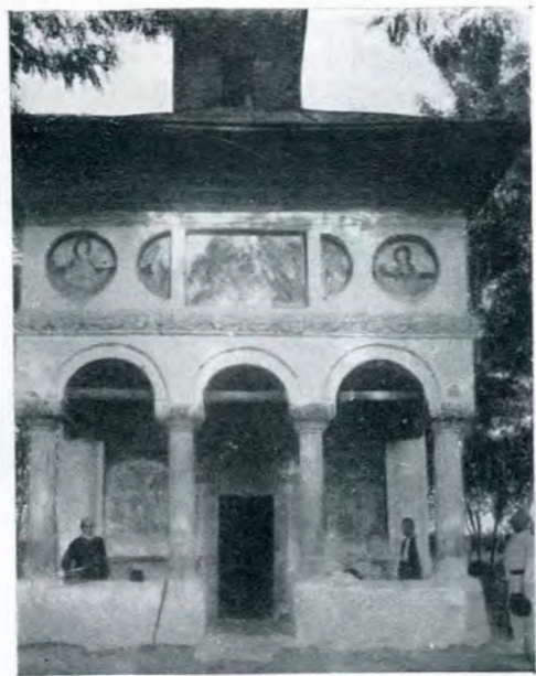
Fig. 346. — Vue du porche
