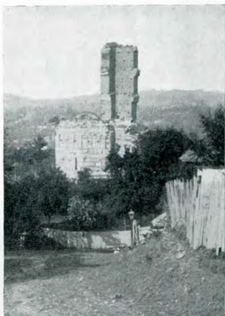
Fig. 5. — Vue générale de San Nicoara.
