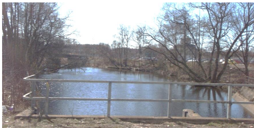
Figur 12: Växtlighet, strandskoning samt kulvertering under Partihallsgatan vid Gullbergsån (fotoriktning mot söder).
