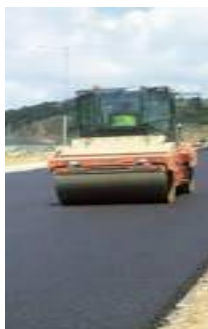
Σχήμα 2.7: Αριστερά: διαμορφωτής γαιών ( grader ), Κέντρο: οδοστρωτήρας με κύλινδρο ( road roller ), Δεξιά: χειροκίνητος τροχήλατος διαγραμμιστής οδών.
