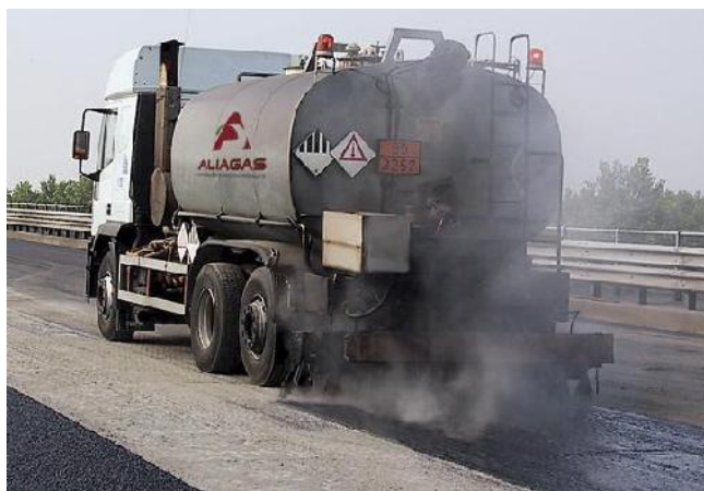
Σχήμα 2.6: Αριστερά: αυτοκινούμενος διανομέας ασφάλτου ( federal ), Δεξιά: διαστρωτήρας ασφάλτου ( finisher ).
