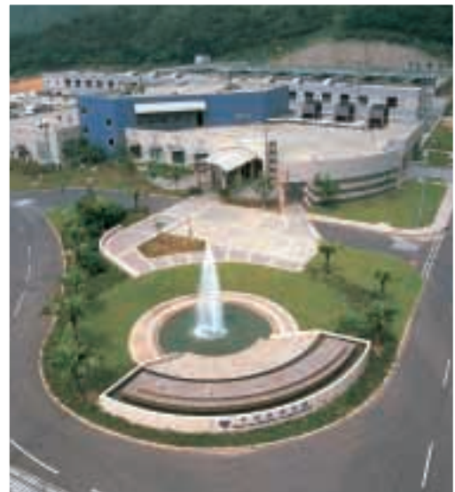
牛潭尾滤水厂 是世界上最先进 的滤水厂之一
