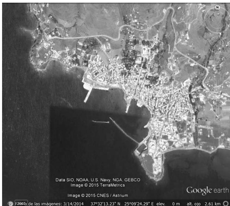
Figura II.172: El área del puerto de Tenos vista del satélite. Google Earth.
