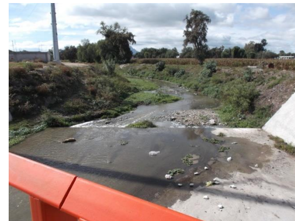
Imagen 18. Puente que en presencia de precipitaciones extremas, el agua del escurrimiento se desborda inundando la vialidad y terrenos contiguos.
