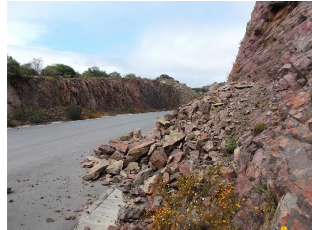
Fotografía tomada en trabajo de campo (Tierras Coloradas)
