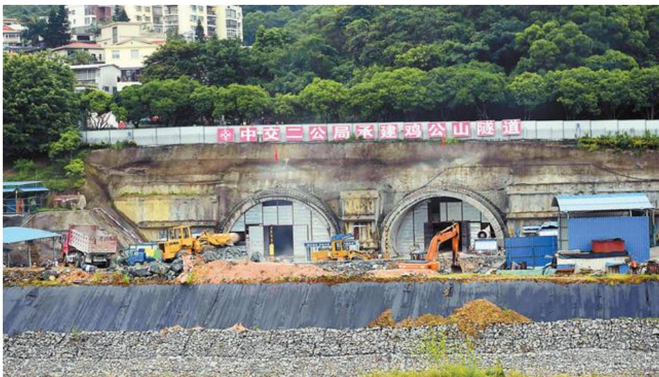
图 5-10 坂银通道工程北侧施工现场
