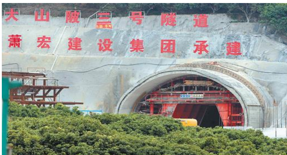
图 5-8 坪山区马峦山段施工现场隧道
