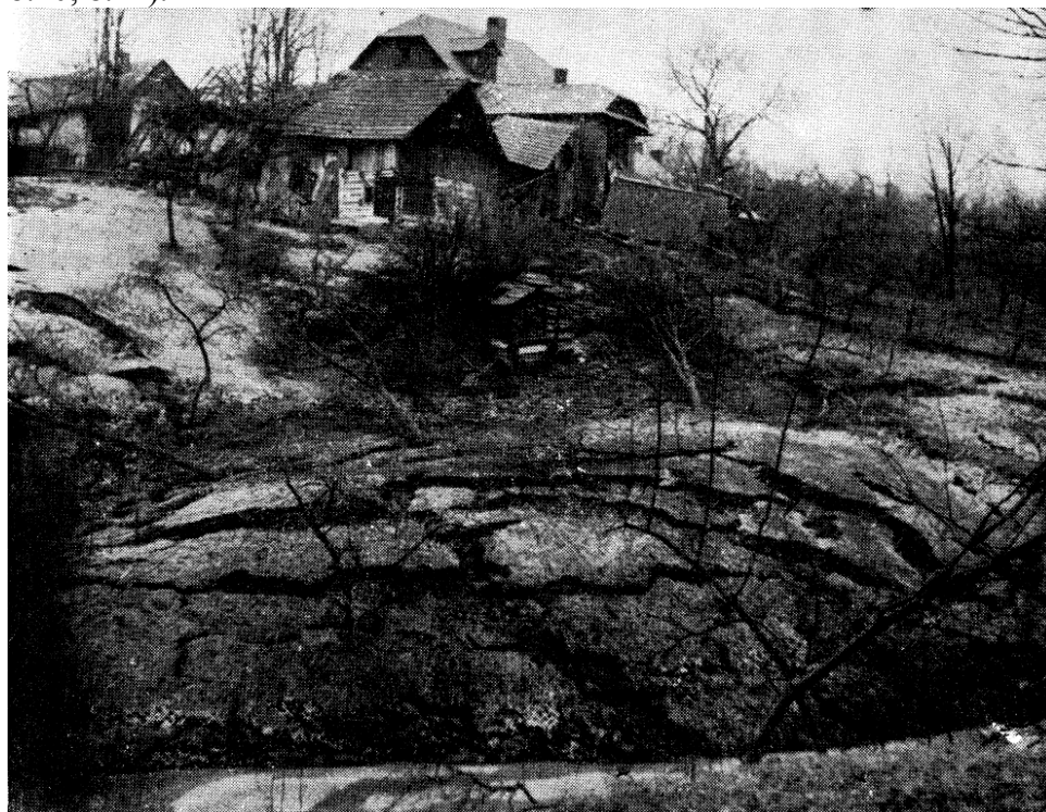
Obr. 8.19 Stavení zničená sesouváním u Handlové v r. 1961 (J. Pašek in Q. Záruba – V. Mencl, 1974)
