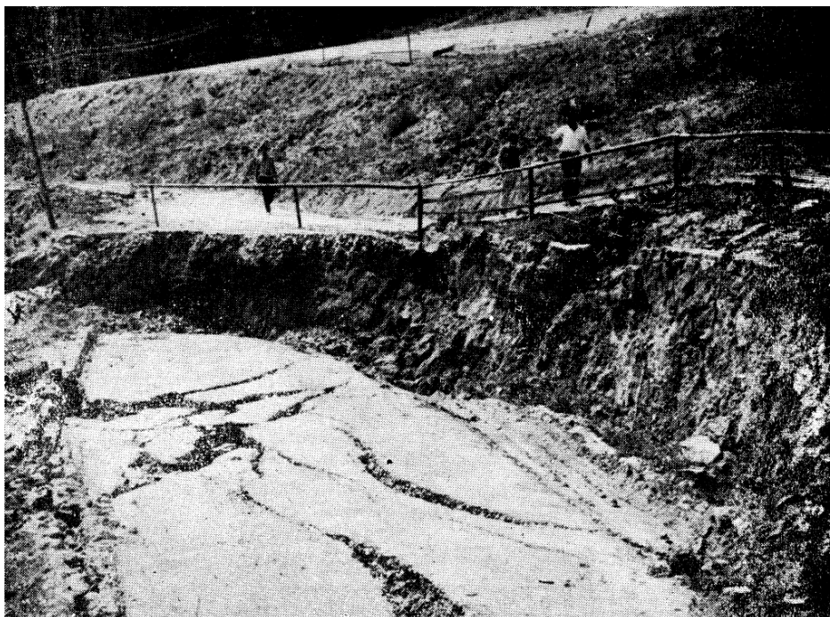
Obr. 8.1 Silnice je přerušena sesuvem svahových sutí, vyvolaným výkopem pro zavázání hráze na Východním Slovensku (Q. Záruba in Q. Záruba – V. Mencl, 1974)
