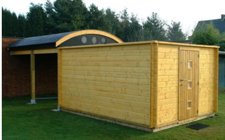
Foto 5/21: Een omgebouwd tuinhuis, het dak rolt weg over twee rails zodat de telescoop en waarnemer een min of meer vrij zicht hebben op de hemel. Opname; Karel Teuwen.
