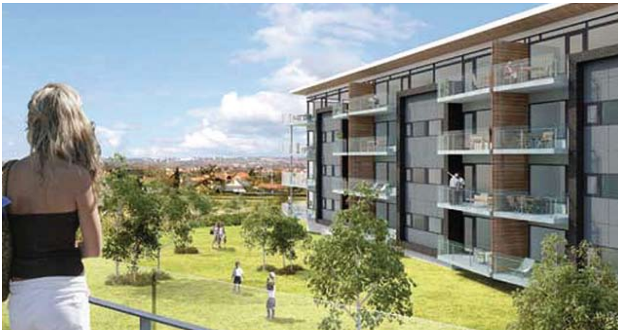
Udsigten, Viby, etageboligbyggeri, bygges 2009-2010 © Sahl Arkitekter
