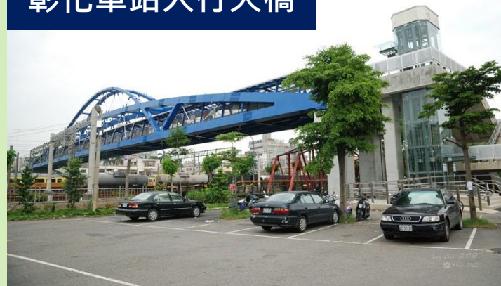
彰化車站人行天橋
