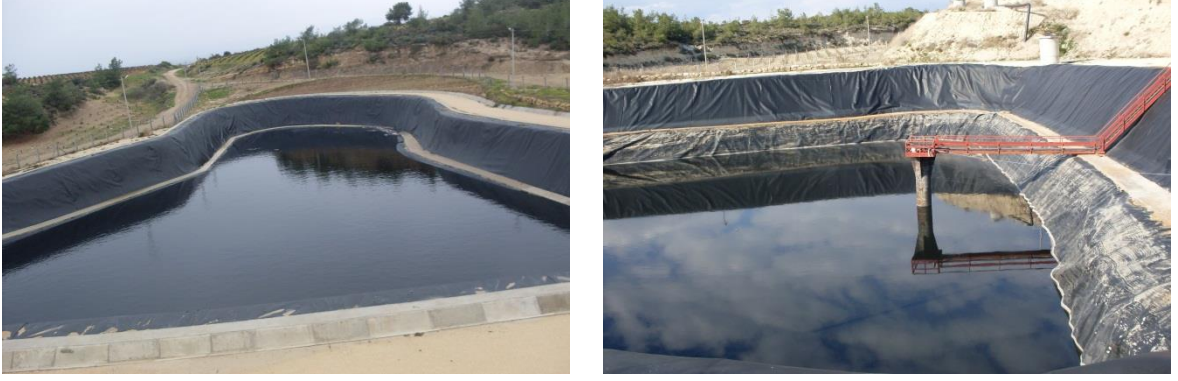
Şekil C.12. Sızıntı Suyu Toplama Lagünü (M.B.B. Başkanlığı, 2012).
