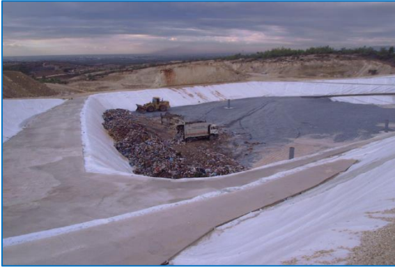
Şekil C.3. Düzenli Depolama Alanı yapım aşaması ve işletme fotoğrafları (M.B.B.Başkanlığı, 2012).
