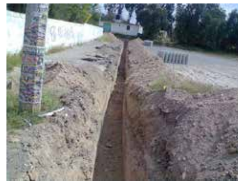
Daxtha. Construcción de drenaje sanitario en la 1era manzana.
