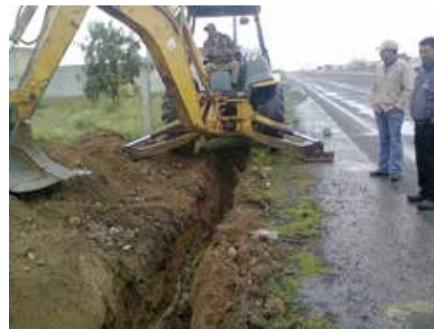
Col. Unidad Deportiva. Construcción de drenaje sanitario.
