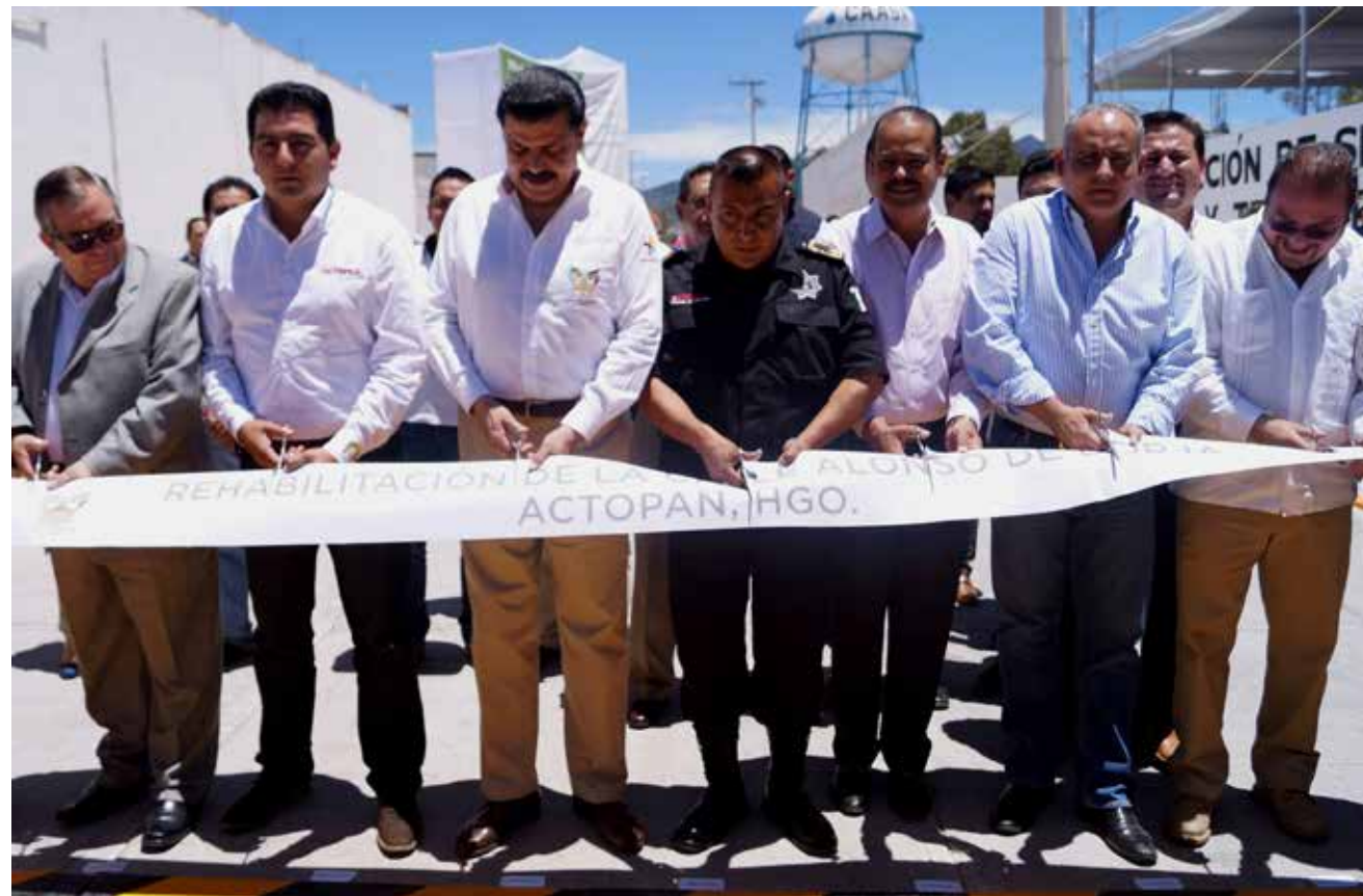
Actopan. Construcción de base hidráulica en Calle Alonso de Borja.
