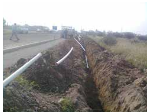
Dajedhi. Construcción de red de agua potable.
