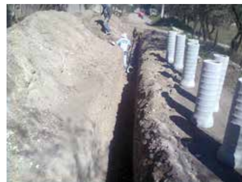
Pozo Grande. Construcción de drenaje sanitario en la Calle Abasolo.
