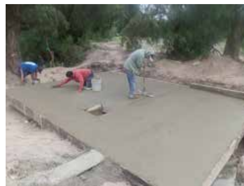
El Palomo. Construcción de fosa séptica.
