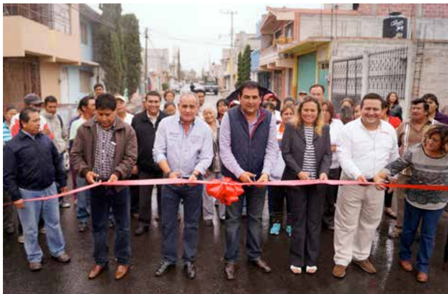
Parque Urbano. Pavimentación con carpeta asfáltica de 5 cm de espesor en Circuito Solidaridad Calle Norte 8 y Norte 2.
