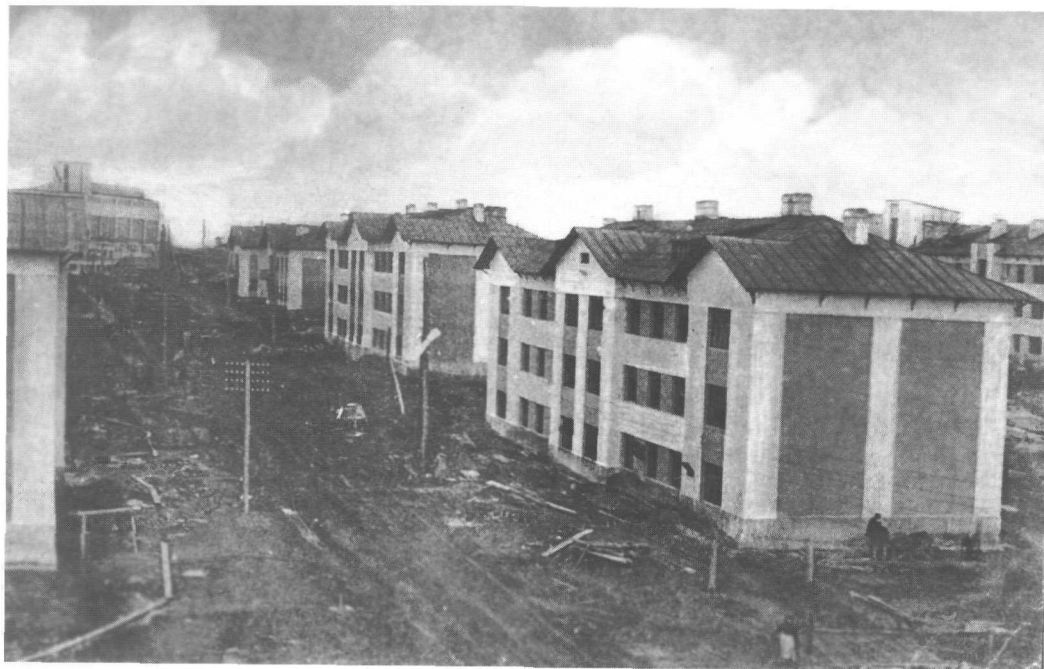
Строительство соцгородка ЧГРЭС (ныне — ул. Российская). С открытия 1929 г.
