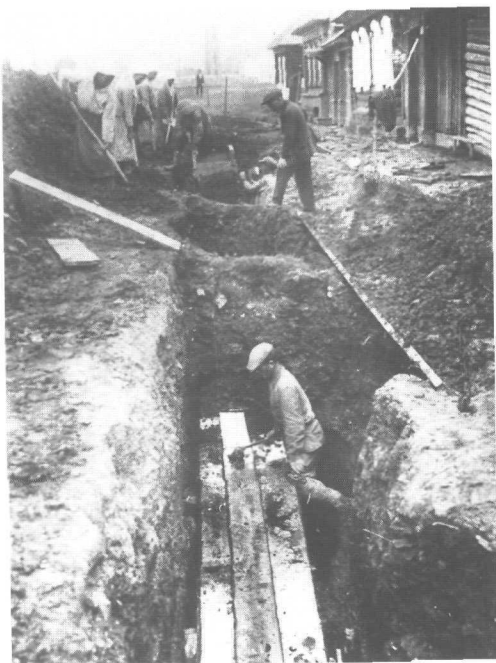
Прокладка водопровода. 1930-е гг.
