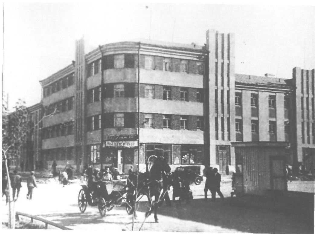
Здание на пересечении улиц Кирова и Коммуны. 1930-е гг.
