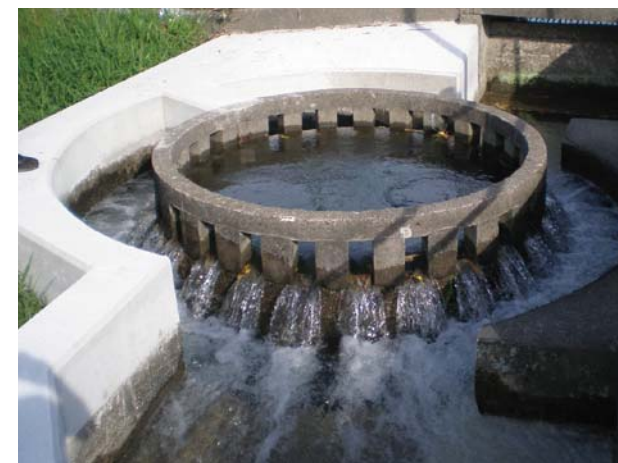
近代に造られた円筒分水(分木方式の一種) (南あわじ市神代浦壁)
