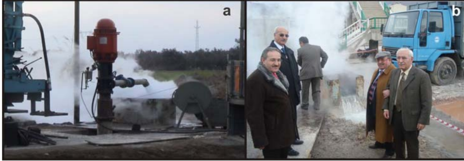
Şekil 4. Kızılcahamam da İller Bankası'na 365 metre derinlikte açılan kuyuda pompa testi
