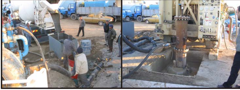
Şekil 8. Edremit EDJ-3 nolu kuyuda çimentolama çalışmaları.
