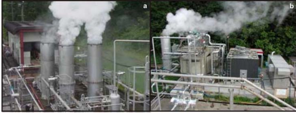
Şekil 4. a) Hijiori-Japonya'da kızgın kuru kaya araştırma aktiviteleri, b) Hijiori'deki deneysel ikili çevrim enerji santrali.
