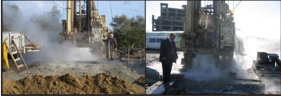
Şekil 9. Edremit EDJ-5 nolu kuyuda inkişaf çalışmaları.
