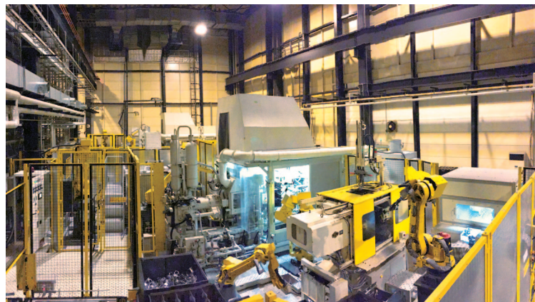
Die casting cell
