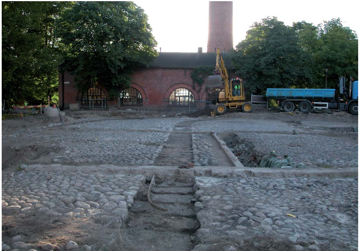
Tampereen Kirjastonpuiston kaivauksia kesällä 2010. Esillä on Frenckellin paperitehtaan teollisuuspihan mukulakiveys 1900-luvun alusta. Kalle Luoto, Pirkanmaan maakuntamuseo.
