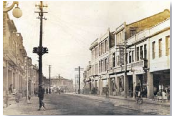
照 3-3-26 昭和 10 年（1935）第二次市區改正，拓寬的順天路。（林福松提供）
