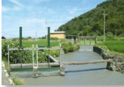
照 3-3-103 虎眼大圳前分水道與水門
