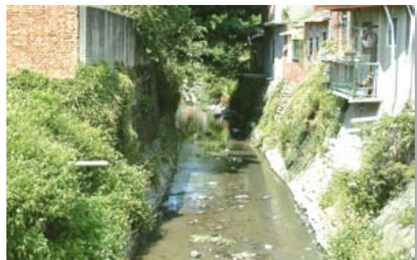
照 3-3-114 位於鐵山村的后里排水溝，疑似楊桂森的掘堤處。
