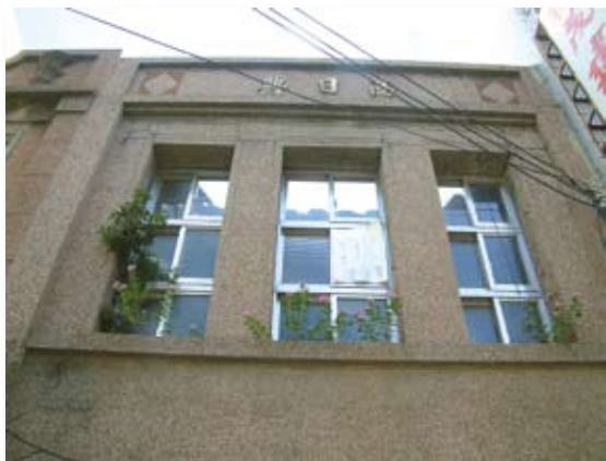
照 3-3-52 昭和 10 年闢建的文武路，留存的舊建築。
