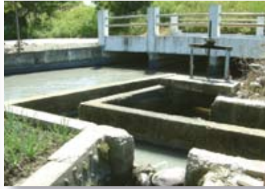
照 3-3-106 虎眼大圳分水門
