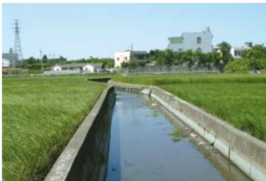
照 3-3-113 位於外埔大東村的后里排水溝源頭。
