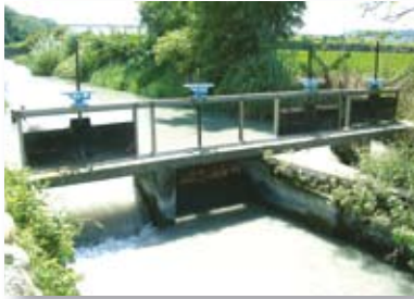
照 3-3-105 虎眼大圳分水門
