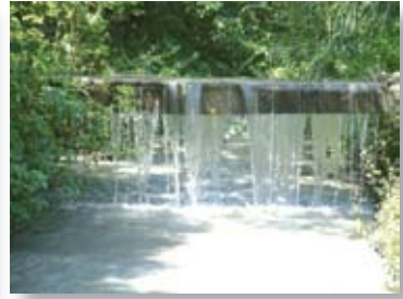
照 3-3-107 虎眼大圳的水橋
