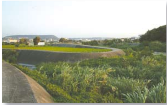
照 3-3-116 后里排水溝與水美溪於橫圳相接
