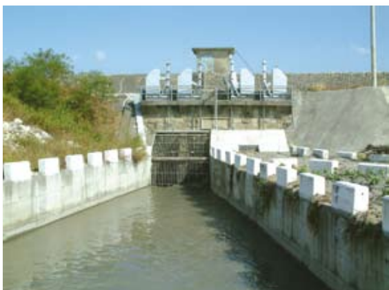
照 3-3-119 日南圳進水口
