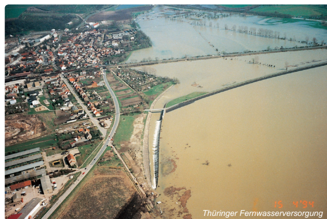
Obr. 4.7-14: Retenční nádrž Straußfurt při povodni v dubnu 1994
