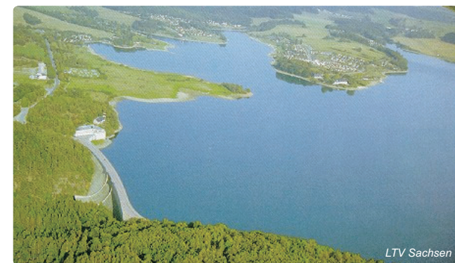
Obr. 4.7-20: Přehrada Pöhl, největší vodní dílo v povodí Bílého Halštrovu
