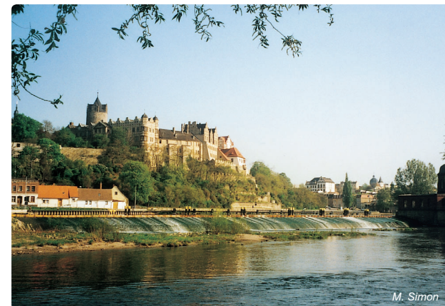
Obr. 4.7-36: Pevný jez na Sále pod zámekem v Bernburgu
