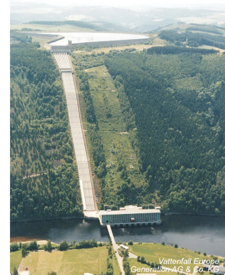
Obr. 4.7-8: Přečerpávací elektrárna Hohenwarte II
