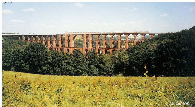
Obr. 4.7-22: Most přes údolí řeky Göltzsch
