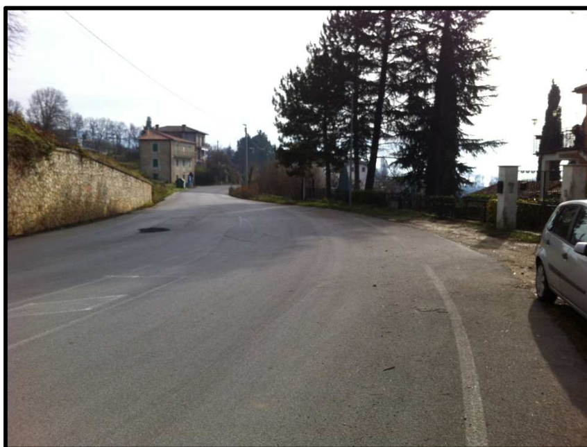
Figura 16 – Assenza di Barriere di Protezione
