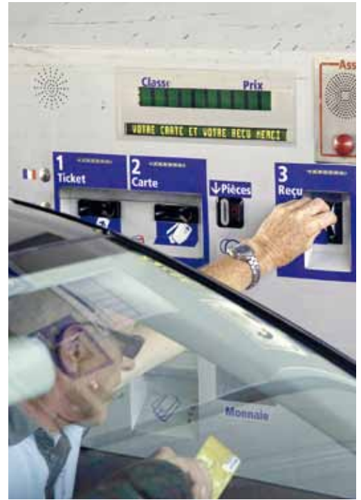
Ci-dessus : borne tout paiement à la barrière de Lançon, sur l'A7. Ci-contre : voie de télépéage à 30 km/h à la barrière de Valence Sud, sur l'A7.
