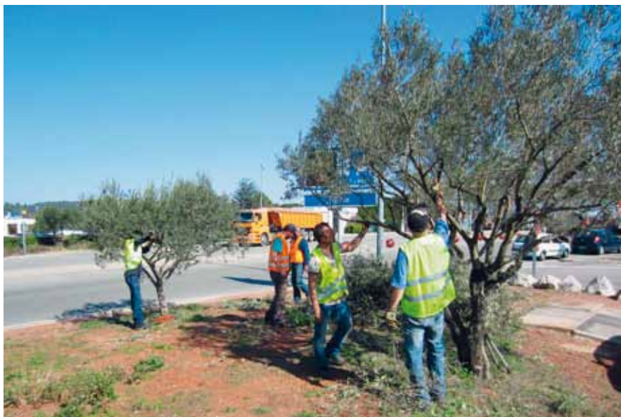
Ci-dessus : taille des oliviers dans une oliveraie conservatoire créée sur l'emprise du réseau Escota ; La Varappe, entreprise d'insertion des Bouches-du-Rhône, travaille en sous-traitance pour VINCI Autoroutes.
