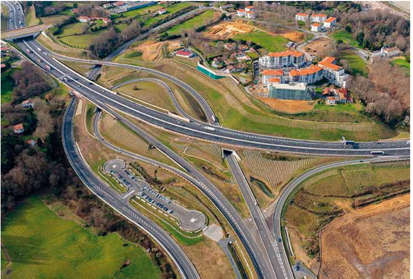
Ci-dessus : réaménagement de l'A63, élargie sur une première section de 18 km, entre Ondres et Biarritz. Page de gauche : en haut, réfection de la couche de roulement sur l'A8, au niveau de Mougins ; en bas, construction d'une barrière de péage sur la nouvelle section de l'A89 vers les portes de Lyon.
