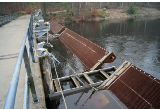
Installation av intagsgaller. Foto: E.ON
