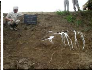
石膏を注入し、穴の探索・追跡調査
