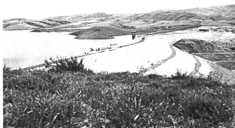
Рис 3. Плотина Топарского водохранилища
