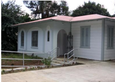
Restauración Casa de Campo Ex-Gobernador Luis Muñoz Marín
