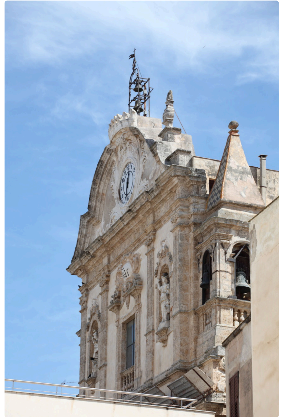
Particolare della facciata principale
