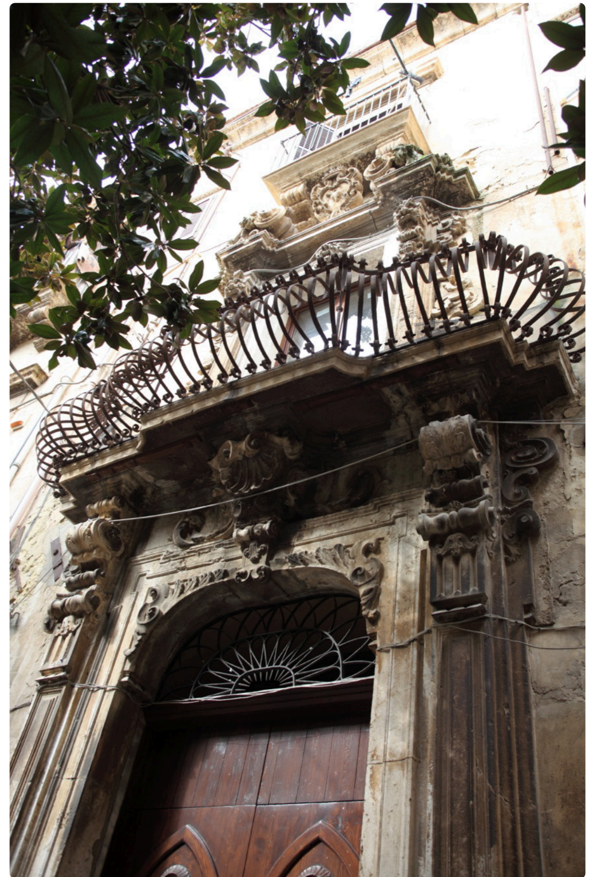
Il portale del palazzo Fraccia
