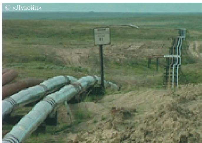
Рисунок 4.16 Местные трубопроводы нефтяных компаний доставляют нефть в систему магистральных нефтепроводов «Транснефти» или на экспортные терминалы. На фото нефтепровод «Лукойла» в тундре Ненецкого автономного округа, по которому нефть поставляется на Варандейский терминал.
