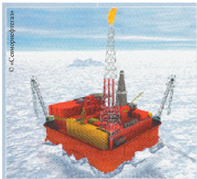
**Рисунок 4.23** Платформа «Приразломная» будет первой промышленной платформой, осуществляющей добычу нефти в арктических водах покрытых льдом шесть месяцев в году. Планируется доставить и установить платформу в Печорском море в течение лета 2005 года, и получить первую промышленную нефть в декабре того же года. Максимальный уровень добычи и экспорта нефти с Приразломного месторождения должен составить 7,5 миллионов тонн в год.
