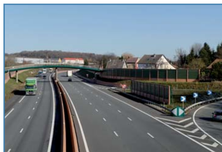
A36 - après l'aménagement de mise à 2x3 voies (source : APRR)
