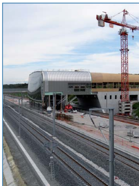
Gare TGV Belfort-Montbéliard en construction - septembre 2010
