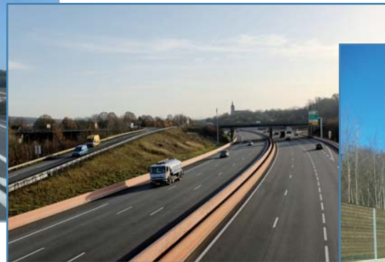
Echangeur de Sévenans (source : APRR)
