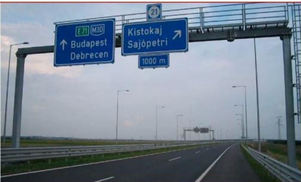
2. Gotowe odcinki Via Carpatia w rejonie Debreczyna
