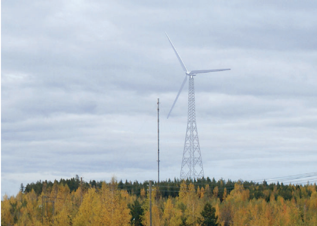
Kuva 32. Ristikkorakenteinen mastotyypin muodostaa hyvin erilaisen maisemavaikutuksen kuin perinteinen.
