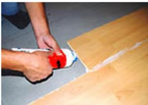
Die Verleimung der Nut-/ Federverbindung muss nach den Vorgaben der Verlegehinweise des Laminatherstellers erfolgen. Bei der HDF-Trägerplatte wird der Leim auf die Oberseite der Feder gegeben, so dass nach dem Zusammenfügen zweier Paneele der Leim nach oben austritt und eine Versiegelung der Fuge gegenüber Feuchtigkeit von oben (z.B. beim Wischen) erreicht wird. Es muss darauf geachtet werden, dass der Leim aus der Fuge tritt und so den Träger versiegelt.
