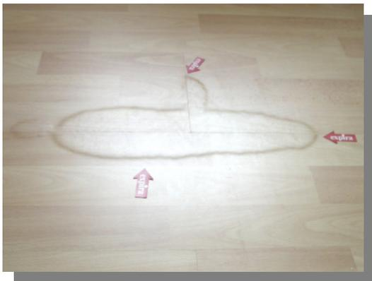
Genauso sieht es aus, wenn Feuchtigkeit auf die Platte einwirkt. Durch die ausgelaufene Flüssigkeit einer umgeworfenen Vase kann es schnell zu einem Schaden kommen bei dem Nähte des Laminatbelages aufquellen und der Bodenbelag dadurch völlig unbrauchbar wird. Aber nicht nur solche Schäden führen zur Zerstörung des Bodenbelages, sondern schon geringe Mengen von Schnee oder Regenwasser, das in einer Pfütze auf dem Laminat stehen bleibt, kann zur Zerstörung des Belages führen.
