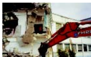
Demolição do Complexo Frei Caneca (Fábio Bruno)
