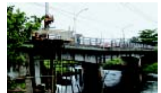
Ponte na Av. João XXIII (Geomecânica)
