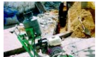
Saneamento de Vargem Pequena (Fercon)
