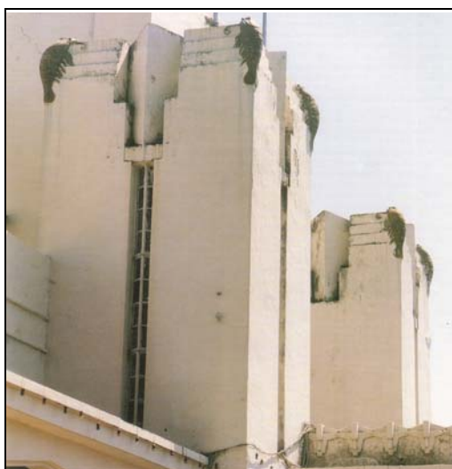
Gambar 20. Salah satu detail pada bangunan balaikota Cirebon.
