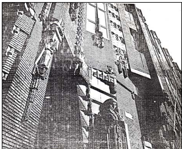
Gambar 4. PINTU masuk utama bangunan Sheepvarthuis, yang sangat impresif ini dirancang oleh arsitek aliran Amsterdam School , (Michael de Klerk, Piet Kramer), yang dibangun pada th. 1912.
